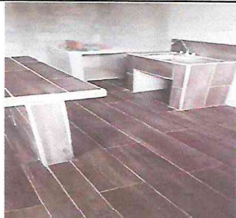
FOTOGRAFIA: SITUACION DE ESTUFA RURAL(COMPLETA) INCLUYE CHIMENEA Y PLANCHA DE METAL,SUSTITUCION DE PISO CERAMICO EN MODULO DE COCINA
