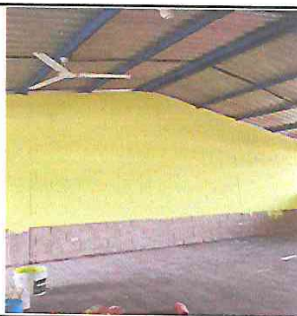
FOTOGRAFIA: PINTURA EN MUROS INTERIOR Y EXTERIOR EN MODULO DE AULAS
