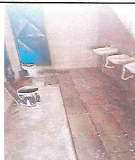
FOTOGRAFIA: REPARACION Y SUSTITUCION DE MINGITORIOS DE VARONES, PINTURA EN MURIS, SUSTITUCION DE PISO ANTIDESLIZANTE EN SERVICIO SANITARIO DE VARONES
