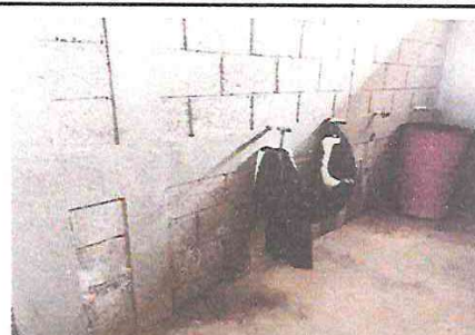
FOTOGRAFIA: REPARACION Y SUSTITUCION DE MINGITORIOS EN BANO DE VARONES, PINTURA EN MUROS, SUSTITUCION DE PISO ANTIDESLIZANTE EN SERVICIO SANITARIO DE VARONES
