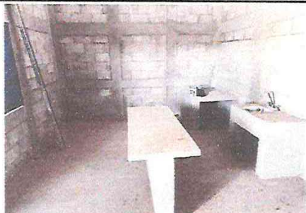
FOTOGRAFIA: SUTITUCION DE ESTUFA RURAL (COMPLETA) INCLUYE CHIMENEA Y PLANCHA DE METAL, SUSTITUCION DE PISO CERAMICO EN MODULO DE COCINA
