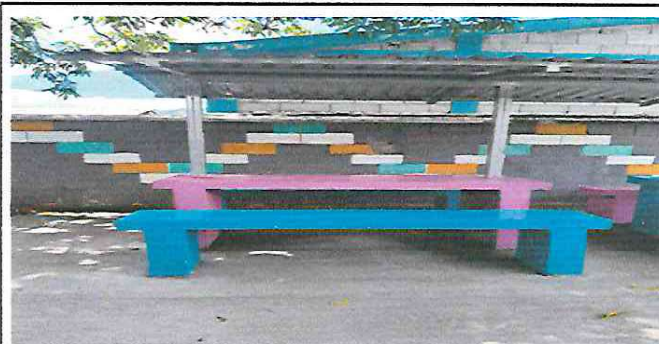
Foto 2: Reparación de mesa recreativa
