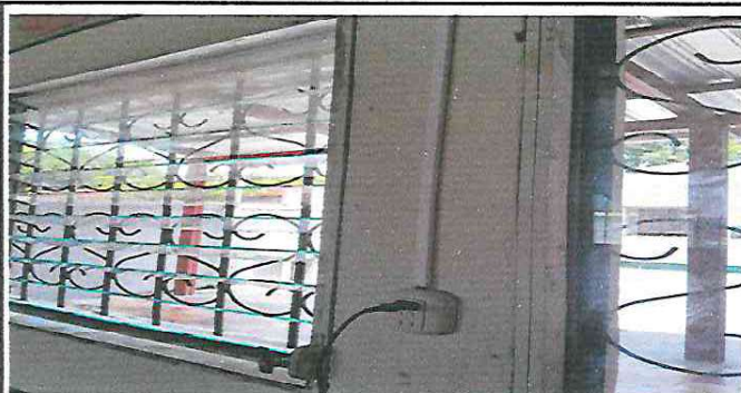
Foto 3: Instalación y sustitución de tomacorrientes
