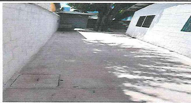
Foto 1: Reparación de piso de concreto en patio
