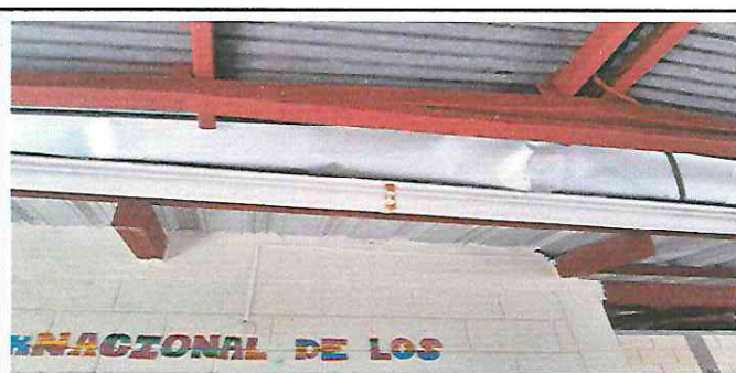
Foto 5: Sustitución de soporte de canal pluvial
