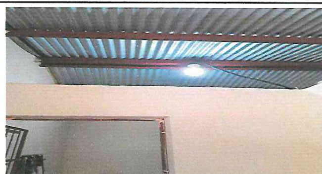
Foto 4: Instalación y sustitución de lámparas Led
