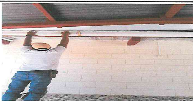
Foto 5: Sustitución de soporte de canal pluvial
