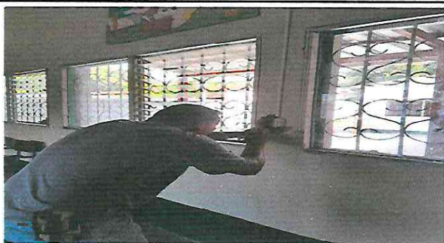
Foto 3: Instalación y sustitución de tomacorrientes
