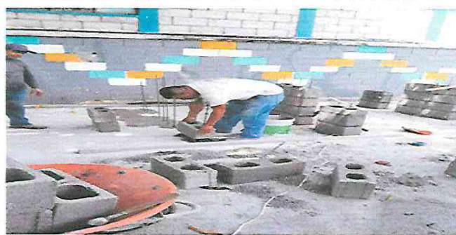
Foto 2: Reparación de mesa recreativa
