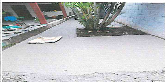
Foto1: Reparación de piso de concreto en patio
