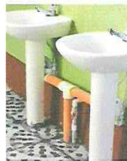
FOTOGRAFÍA No. 8 SUSTITUCIÓN DE TUBERÍA
