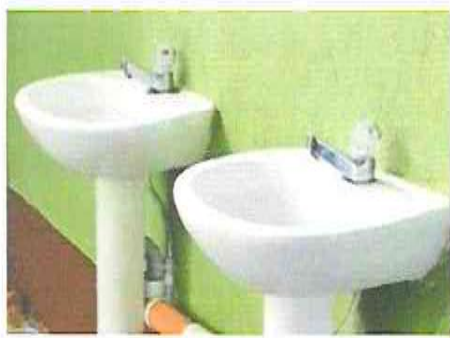
FOTOGRAFÍA No. 9 SUSTITUCIÓN DE GRIFOS
