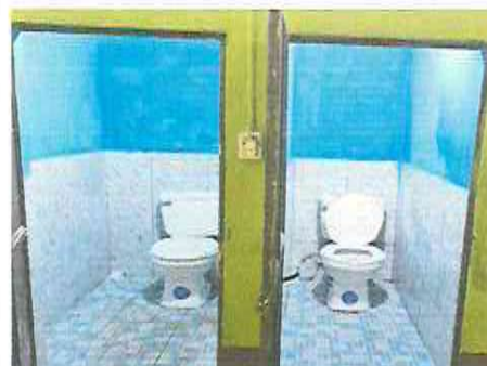
FOTOGRAFÍA No. 10 SUSTITUCIÓN DE SERVICIOS SANITARIOS
