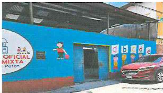
FOTOGRAFÍA No. 7 PINTURA EN MUROS EXTERIOR E INTERIOR
