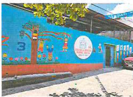
FOTOGRAFÍA No. 3 REPARCIÓN DE MURO DE BLOCK
