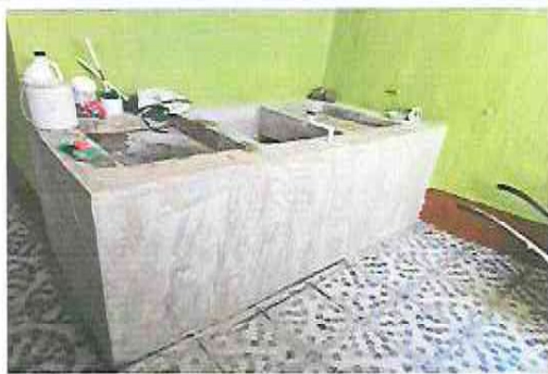
FOTOGRAFÍA No.1 SUSTITUCIÓN DE PILA DE DOS LAVADEROS
