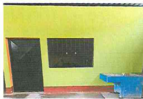
FOTOGRAFÍA No. 6 CERNIDO EN MUROS
