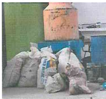
FOTOGRAFÍA No. 1 SUSTITUCIÓN DE PILA DE DOS LAVADEROS
