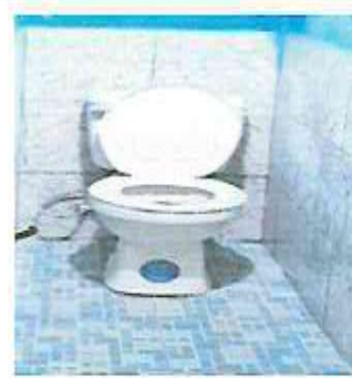
FOTOGRAFÍA No. 10 SUSTITUCIÓN DE SERVICIOS SANITARIOS
