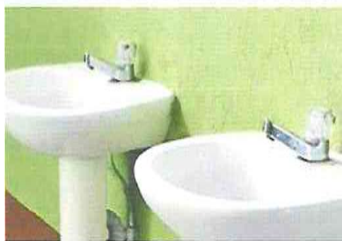
FOTOGRAFÍA No. 9 SUSTITUCIÓN DE GRIFOS
