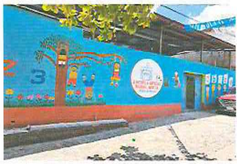
FOTOGRAFÍA No. 7 PINTURA EN MUROS EXTERIOR E INTERIOR
