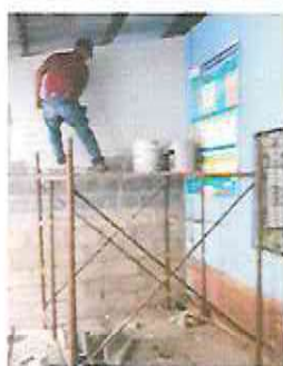
FOTOGRAFÍA No. 5 REPELLO Y SANITIZACIÓN EN MUROS
