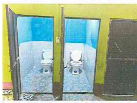
FOTOGRAFÍA No. 4 MANTENIMIENTO DE PUERTAS DE SERVICIOS SANITARIOS
