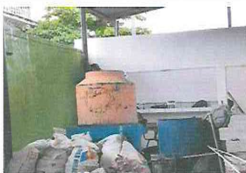
FOTOGRAFÍA No. 3 REPARACIÓN DE MURO DE BLOCK
