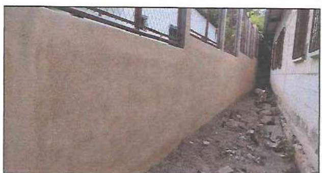
Foto 6: Trabajo terminado en aplicación de pintura en muros interior en terminado de cernido parte de atrás de aulas.
