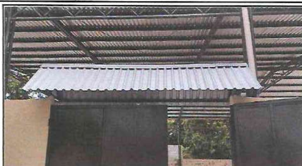
Foto 8: Trabajo finalizado de instalación de techo de lámina troquelada e instalación de estructura metálica arriba de portón.
