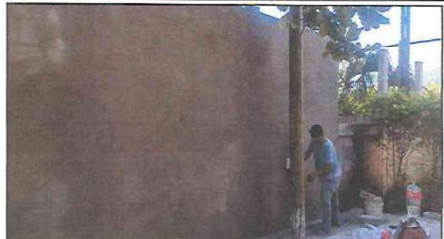
Foto 2: Finalización de reparación de muro perimetral (repello y cernido).
