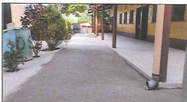
Foto 9: Módulo Losa de Patio. Finalización de trabajo en sustitución de torta de piso de concreto con acabado alisado.
