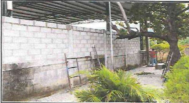
Foto1: Módulo Muro Perimetral. Trabajo terminado de sustitución de malla por bolck en muro perimetral, altura de 1.50 metros.
