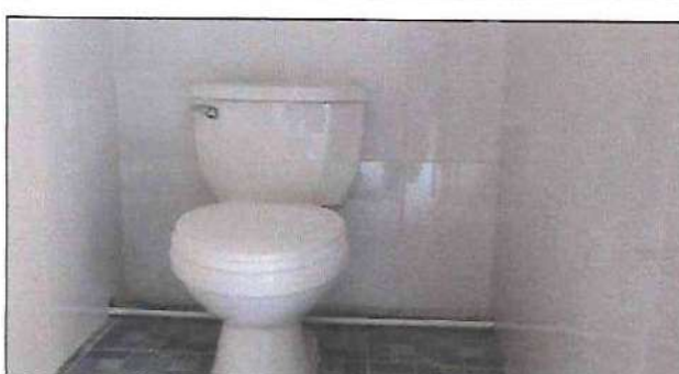
Foto 12: Módulo Baños. Trabajo terminado de colocación de inodoro más accesorios.
