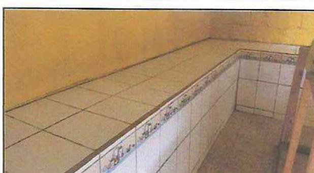
Foto 10: Módulo Cocina. Trabajo realizado en instalación de azulejo en meson de concreto.
