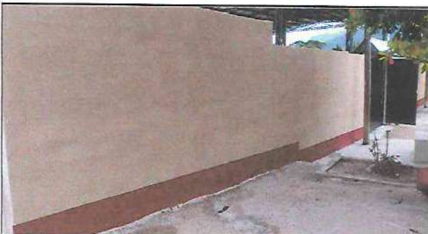
Foto 3: Trabajo terminado en aplicación de Pintura en muros interior y exterior en terminado de cernido.
