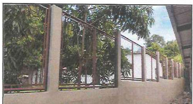
Foto 4: Finalización de mantenimiento de malla y pintura en tubos de metal en muro perimetral parte de atrás de aulas.
