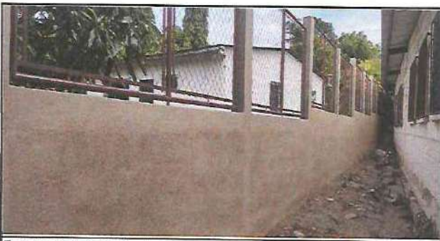
Foto 5: Trabajo finalizado en reparación de muro perimetral parte de atrás de aulas (repello y cernido).
