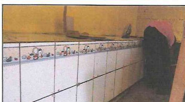
Foto 10: Módulo Cocina. Trabajando en instalación de azulejo en meson de concreto.
