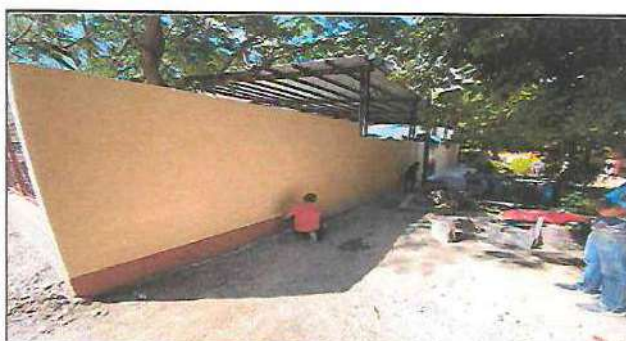
Foto 3: Aplicación de Pintura en muros interior y exterior en terminado de cernido.
