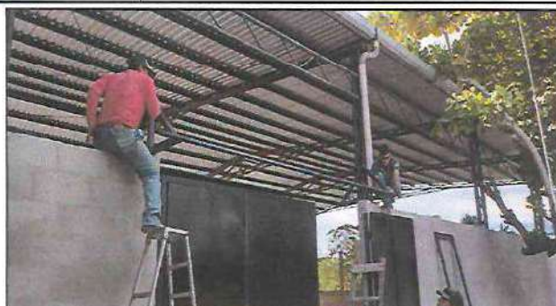
Foto 8: Trabajando en instalación de techo de lámina troquelada e instalación de estructura metálica arriba de portón.
