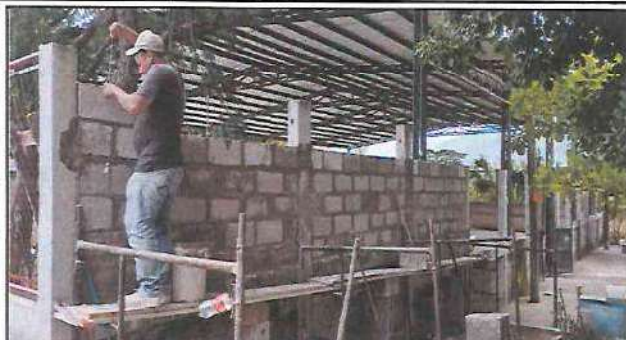
Foto1: Módulo Muro Perimetral. Trabajando en sustitución de malla por bolck en muro perimetral, altura de 1.50 metros.
