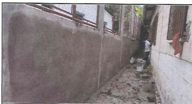
Foto 5: Reparación de muro perimetral parte de atrás de aulas (repello y cernido).
