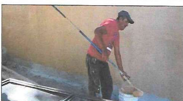
Foto 6: Aplicación de pintura en muros interior en terminado de cernido parte de atrás de aulas.
