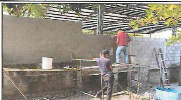
Foto 2: Reparación de muro perimetral (repello y cernido).
