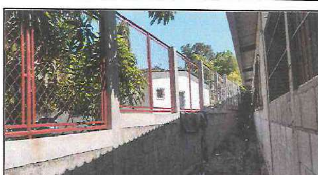
Foto 4: Trabajando en Mantenimiento de malla y pintura en tubos de metal en muro perimetral parte de atrás de aulas.
