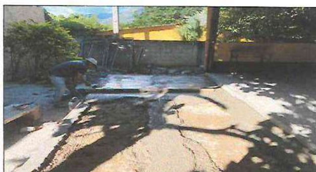
Foto 9: Módulo Losa de Patio. Trabajando en sustitución de torta de piso de concreto con acabado alisado.
