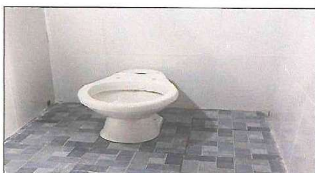
Foto 12: Módulo Baños. Colocación de inodoro más accesorios.
