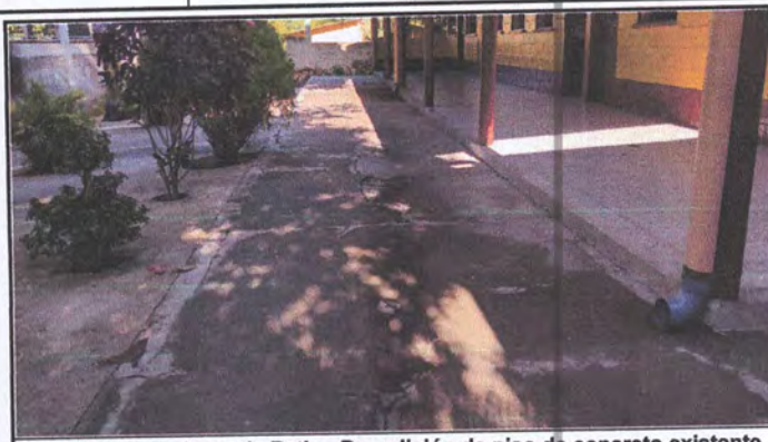
Foto 8: Módulo Losa de Patio. Demolición de piso de concreto existente y sustitución de torta de piso de concreto.
