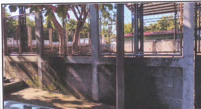
Foto 3: Pintura en muros interior y exterior en terminado de cernido.
