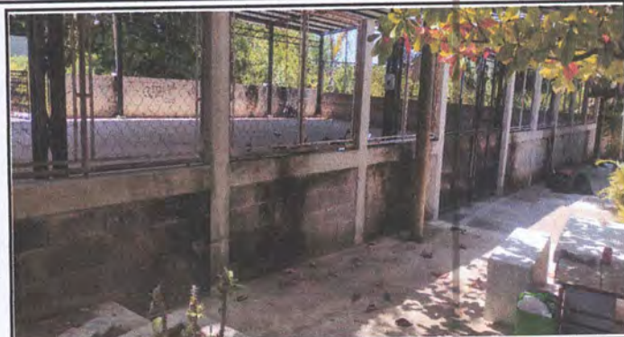
Foto 2: Reparación de muro perimetral (repello y cernido).
