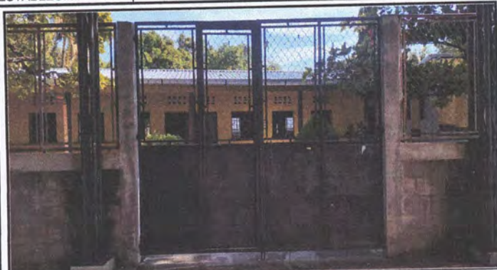
Foto 7: Módulo Portón. Sustrucción de portón de metal. Instalación de techo de lámina troquelada arriba de portón. Instalación de estructura metálica arriba de portón.
