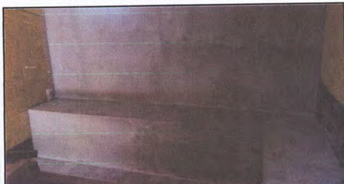
Foto 9: Módulo Cocina. Instalación de azulejo en meson de concreto.
