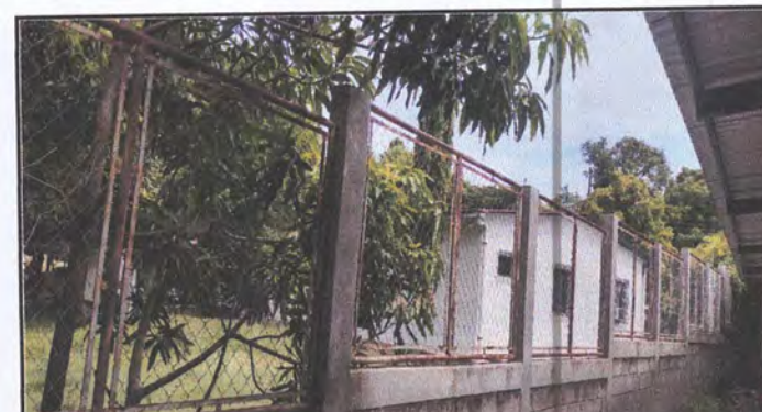
Foto 4: Mantenimiento de malla y pintura en tubos de metal en muro perimetral parte de atrás de aulas.
