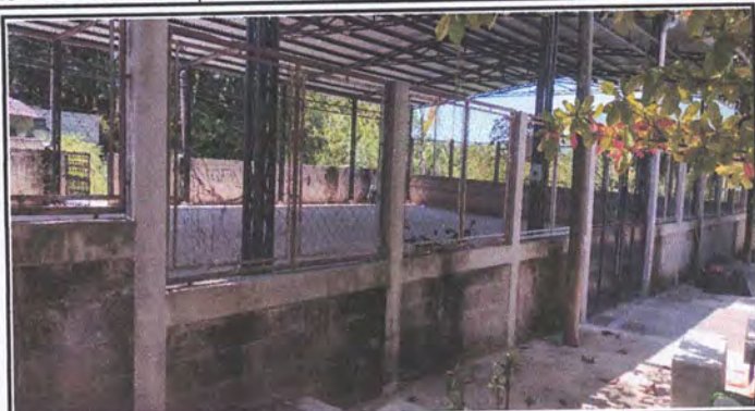
Foto 1: Módulo Muro Perimetral. Sustitución de malla por bolck en muro perimetral, altura de 1.50 metros.
