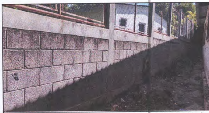
Foto 6: Pintura en muros interior en terminado de cernido parte de atrás de aulas.
