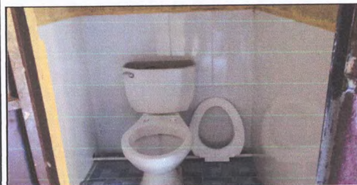
Foto 11: Módulo Baños. Sustrucción de inodoro más accesorios.
