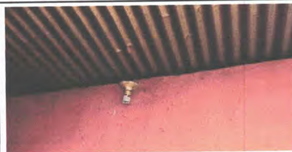
Foto 12: Sustitución de focos ahorradores y plafoneras
