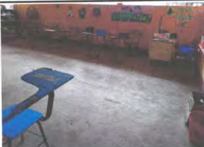
Foto 5: Reparación de piso de torta de concreto(nivelar la base), sustitución de piso de torta de concreto a piso cerámico con zócalo en aula 1
