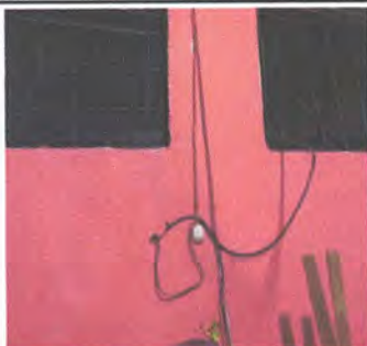
Foto 13: Sustitución de interruptores simples
