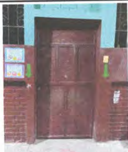
foto 1. Mantenimiento a estructura de metal de puerta en aula 1
