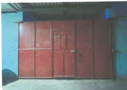
Foto 9: Mantenimiento a portón de metal
