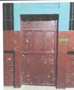
foto 2. Mantenimiento a estructura de metal de puerta en aula 2
