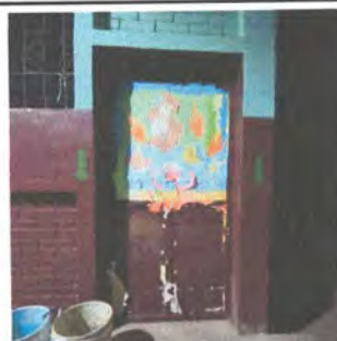
foto 4. Mantenimiento a estructura de metal de puerta en aula 4
