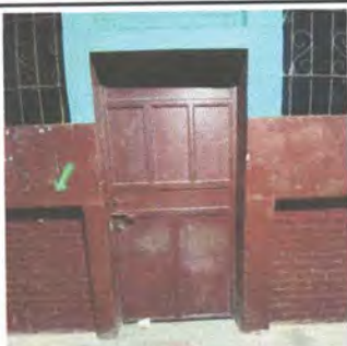
foto 3. Mantenimiento a estructura de metal de puerta en aula 3
