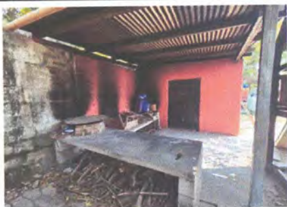
Foto 11: Instalación de azulejo en estufa rural
