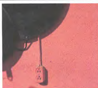
foto 14: Sustitución de tomacorrientes dobles
