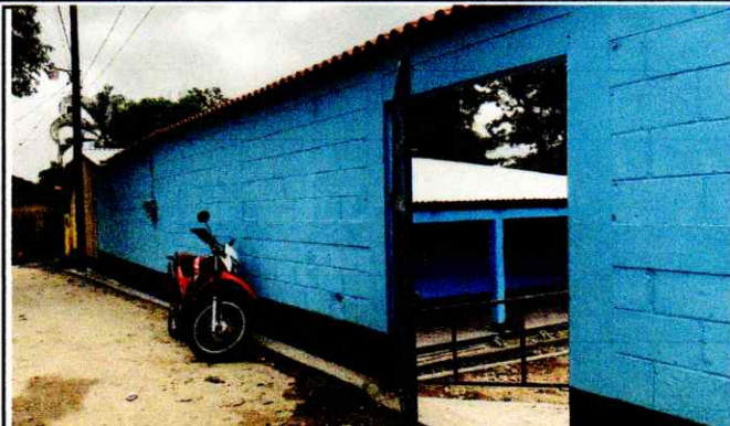
Foto 2: Muro exterior de la escuela
