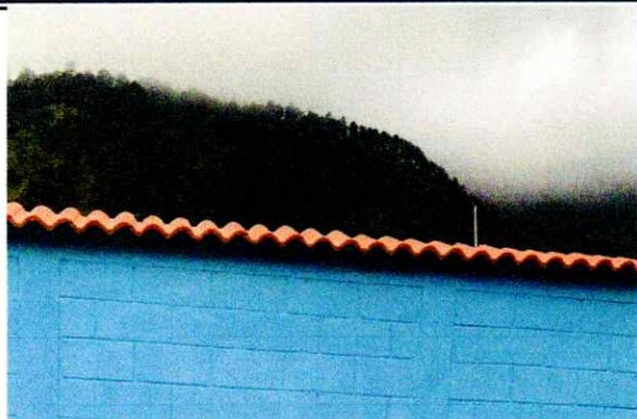
Foto1: Muro exterior del establecimiento
