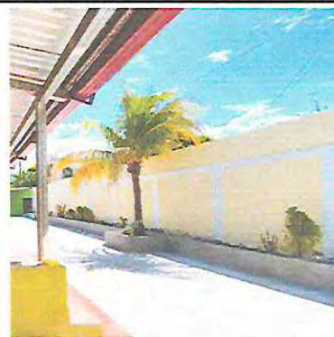
foto 14. Repello, cernido y pintura en muro perimetral lado interno
