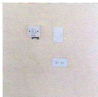
foto 5. Sustitución de tomacorrientes dobles aula 1
