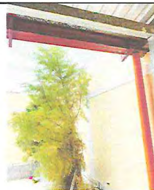
foto 16. Reparación de bajada de agua pluvial
