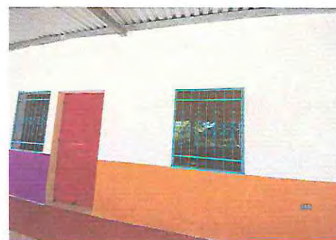
foto 10. Repello, cernido y pintura en muro exterior aula 2
