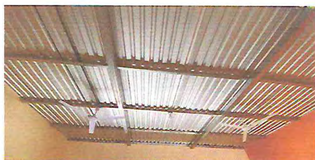
foto 11. Sustitución de lámina por lámina troquelada aluzin calibre 26, sustitución de estructura de soporte de madera por metal, levantado de muro con block para elevar el techo de lámina
