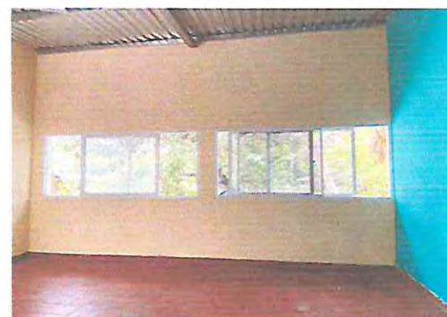
foto 6. Levantado de muro con bloé para elevar el techo de lamina aula 1
