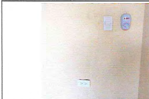
foto 13. Sustitución de tomacorrientes dobles aula 2
