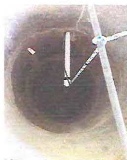
foto 17. Sustitución de Bomba de agua
