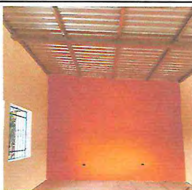
foto 9. Repello, cernido y pintura en muro interno aula 2
