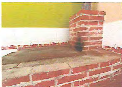
foto 7. Mantenimiento de estufa rural
