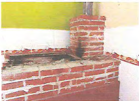
foto 7. Mantenimiento de estufa rural
