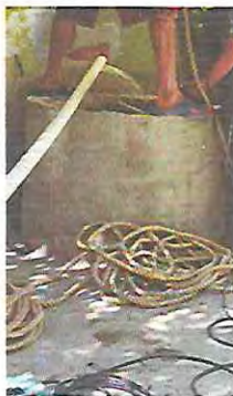
foto 17. Sustitución de Bomba de agua
