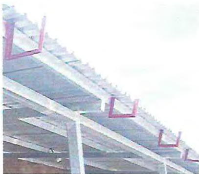
foto 15. Sustitución de canal de metal y soporte de metal para canal en el corredor
