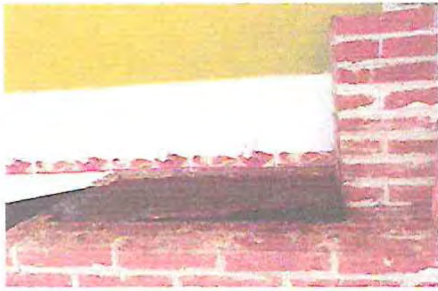
foto 7. Mantenimiento de estufa rural
