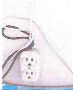
Foto 5. Sustitución de tomacorrientes dobles aula 1
