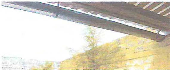
Foto 15. Sustrucción de canal de metal y de soporte de metal para canal en el corredor
