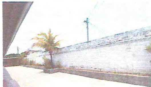
Foto 14. Repello, cernido y pintura en muro perimetral lado interno
