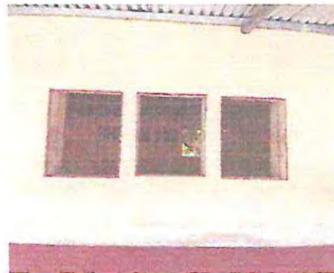
Foto 10. Repello, cernido y pintura en muro externo aula 2
