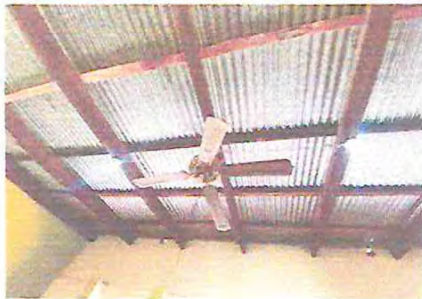
Foto 11. Sustitución de lámina por lámina troquelada aluzin calibre 26, sustitución de estructura de soporte de madera por metal, levantado de muro con block para elevar el techo de lámina
