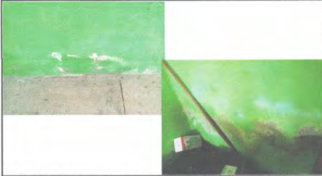
Foto1: Reparación de paredes y resanar y pintar
