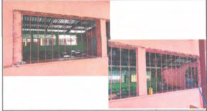
Foto 2: Reparacion de balcones con maya (tipo mosquitero)
