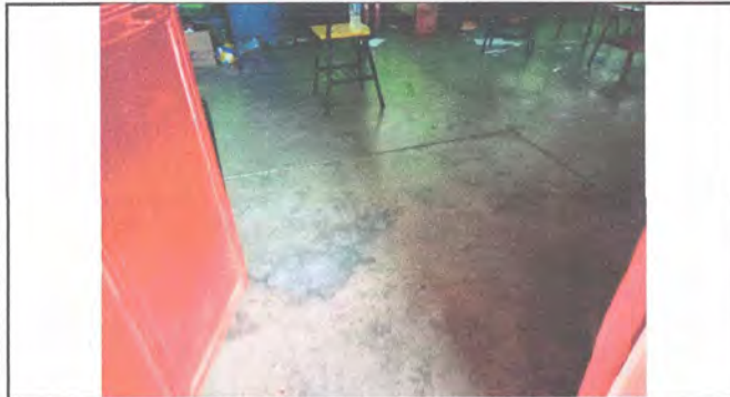
Foto 3: Sustitucion de piso ceramico
