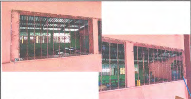
Foto 6: Pintura de balcon
