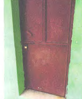
Foto 4: Mantenimiento y estructura (lijado, cambio de tubo, capilado, sujeciones, aplicación de pintura de servicios sanitarios)
