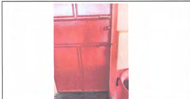
Foto 5: Pintura de puerta
