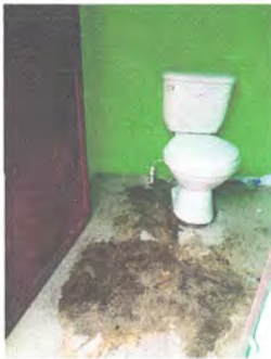
Foto 3: Sustitucion de inodoro
