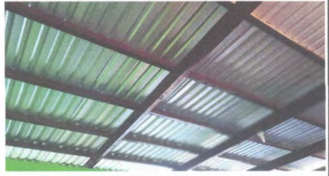
Foto 4: Sustitucion de plafoneras
