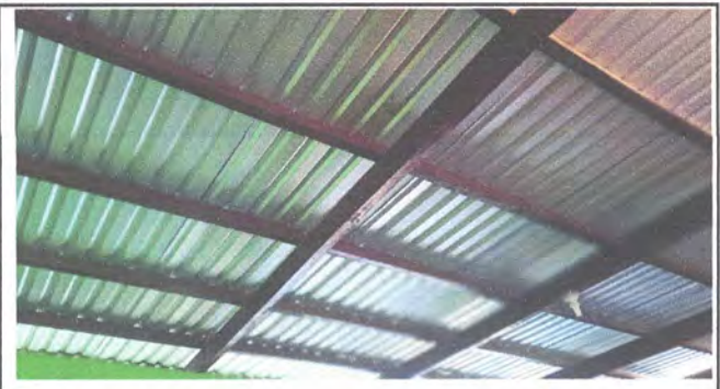
Foto 2: Suministro de cielo falso
