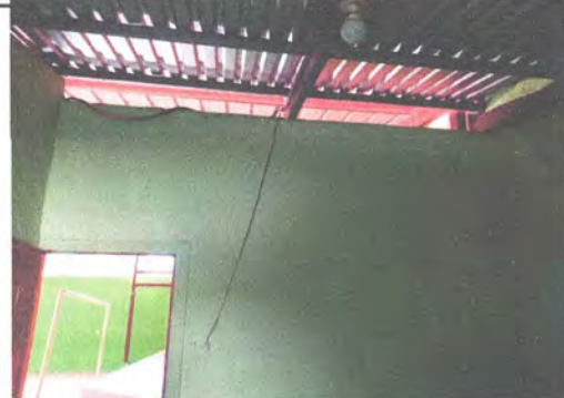
Foto 2: Pintura de paredes
