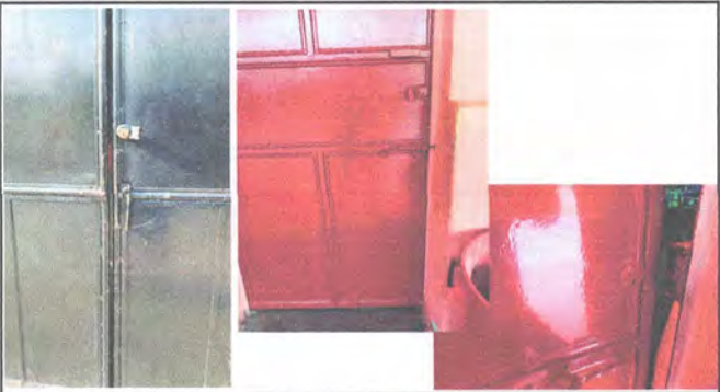
Foto 4: Cambio de chapas
