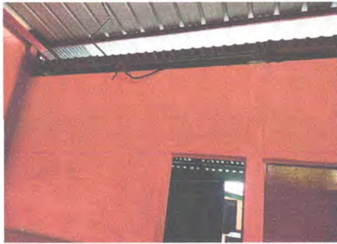
Foto 3: Reparacion de cableado electrico
