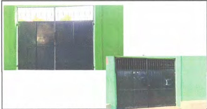
Foto 6: Cambio de chapa y pintura del porton
