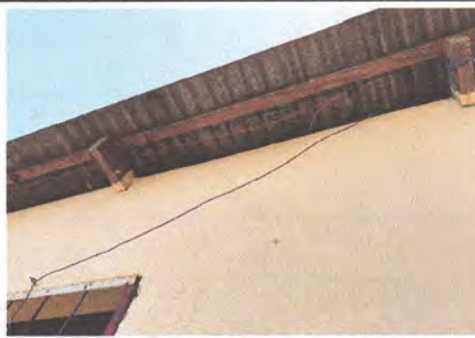
FOTOGRAFIA: SUSTITUCION DE LAMINA, POR LAMINA TROQUELADA CALIBRE 26, SUSTITUCION DE ESTRUCTURA DE SOPORTE DE MADERA, POR METAL EN MODULO DE COMPUTACION
