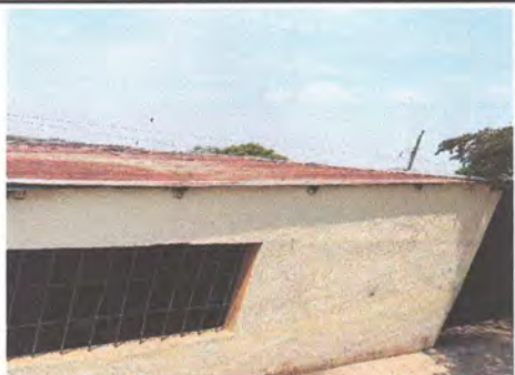
FOTOGRAFIA: SUSTITUCION DE LAMINA, POR LAMINA TROQUELADA CALIBRE 26, SUSTITUCION DE ESTRUCTURA DE SOPORTE DE MADERA, POR METAL EN MODULO DE SALON DE MAESTROS
