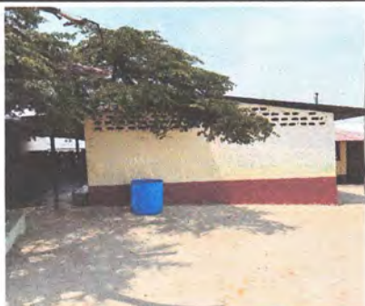
FOTOGRAFIA: SUSTITUCION DE LAMINA, POR LAMINA TROQUELADA CALIBRE 26, SUSTITUCION DE ESTRUCTURA DE SOPORTE DE MADERA, POR METAL EN MODULO DE COMPUTACION
