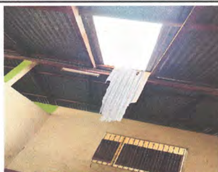
FOTOGRAFIA: SUSTITUCION DE LAMINA, POR LAMINA TROQUELADA CALIBRE 26, SUSTITUCION DE ESTRUCTURA DE SOPORTE DE MADERA, POR METAL EN MODULO DE COMPUTACION
