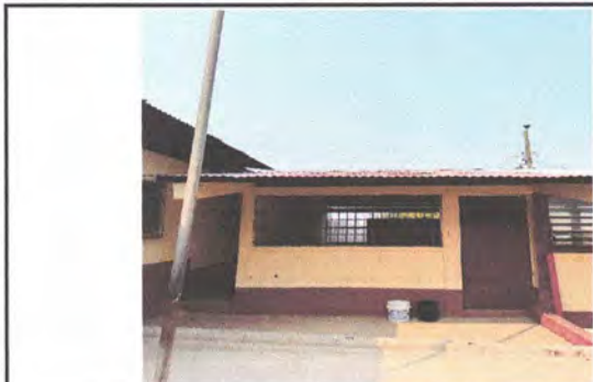
FOTOGRAFIA: SUSTITUCION DE LAMINA, POR LAMINA TROQUELADA CALIBRE 26 EN MODULO DE AULAS
