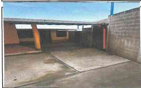
Foto 6: Terminación de Proyecto Galera de lamina, torta de Cemento de 10cm y bajadas de Agua
