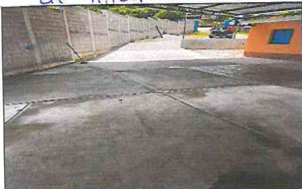
Foto 5: Terminación de Proyecto Completo
