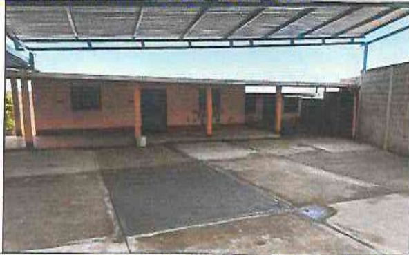
Foto 3: Terminación de bajadas de Agua
