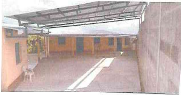
Foto 1: Galera y torta de cemento terminada
