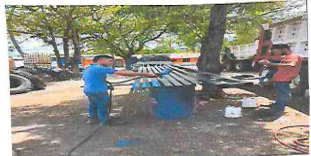
Foto 2: Pintando Costaneras para Estructura de Galera
