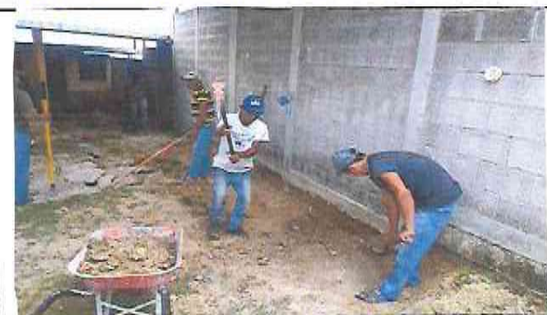
Foto 5: Nivelación de terreno donde va Torta de cemento
