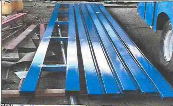
Foto 1: Elaboración de Estructura de Galera
