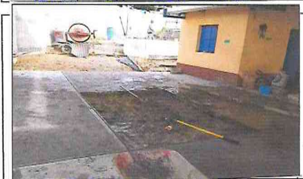
Foto 6: Terminando encementado de Patio.
