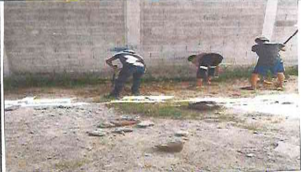
Foto 4: Limpiando Area donde va Torta de cemento
