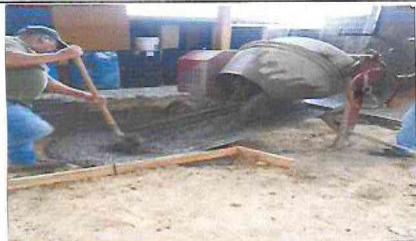
Foto 3: Haciendo mezcla para torta de cemento
