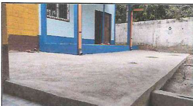
Foto 15: Módulo Losa de Patio. Trabajo realizado de sustitución de torta de piso de concreto en patio.
