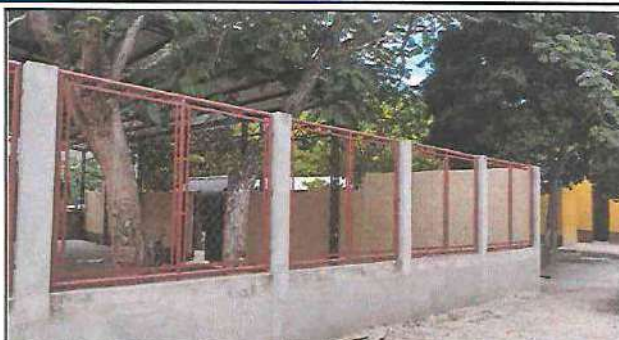
Foto 14: Trabajo finalizado de mantenimiento de malla y pintura en tubos de metal en muro perimetral.
