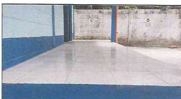
Foto 6: Trabajo terminado de sustitución de torta de concreto e instalación de piso cerámico en corredor de aula.
