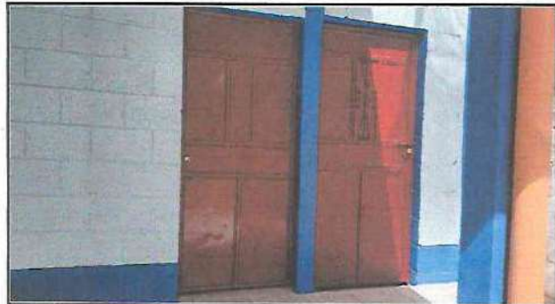
Foto 8: Trabajo realizado de mantenimiento de puertas de metal (corte + pintura).
