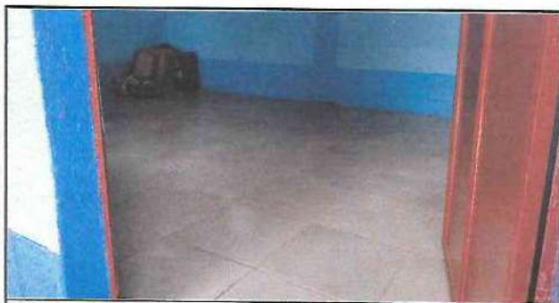
Foto 5: Trabajo terminado de sustitución de torta de concreto e instalación de piso cerámico dentro de aula.
