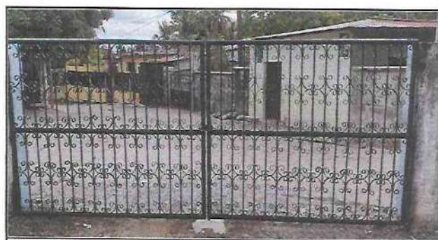
Foto 12: Módulo Portón. Trabajo realizado en mantenimiento de portón de metal entrada principal (pintura anticorrosiva).
