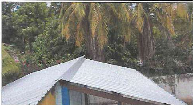
Foto 1: Módulo Aula. Finalización de sustitución de lámina por lámina troquelada cal. 26.
