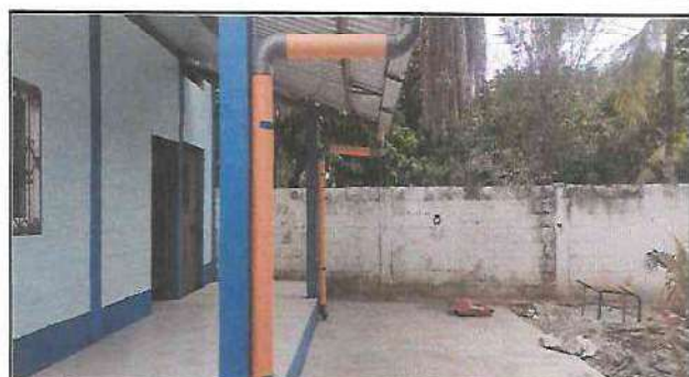
Foto 10: Finalización de instalación de tubos PVC y sus accesorios para bajada de agua pluvial.
