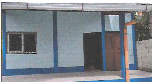
Foto 3: Trabajo terminado de pintura en muros interiores y exteriores, en muros de block rústico.
