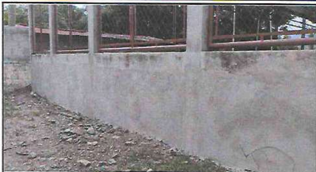
Foto 13: Módulo Muro Perimetral. Trabajo realizado de repello y cernido en muro perimetral.
