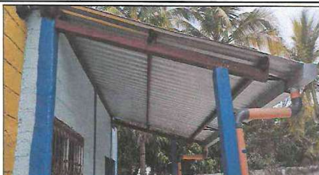
Foto 2: Trabajo finalizado del mantenimiento (pintura) en estructura metálica de techo.
