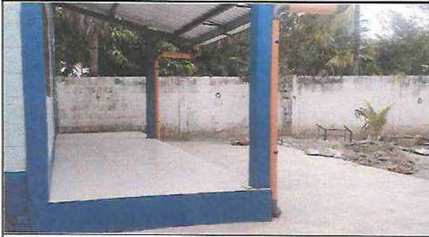
Foto 7: Terminación de sustitución de columnas de metal por columnas de concreto de 2.50 metros de altura.
