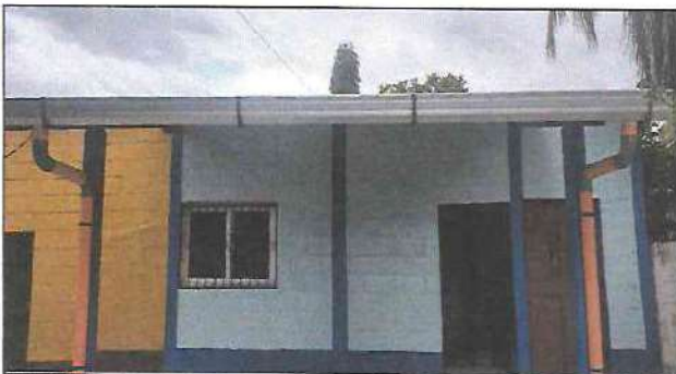
Foto 9: Finalización de instalación de canal para agua pluvial.
