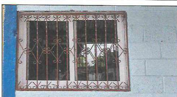
Foto 4: Finalización de mantenimiento en balcones de metal y colocación de ventanas de PVC.
