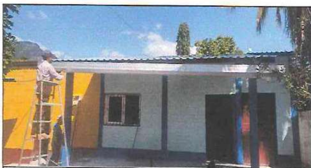
Foto 11: Instalación de canal para agua pluvial.
