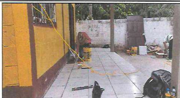
Foto 8: Trabajando en instalación de piso cerámico en corredor de aula.
