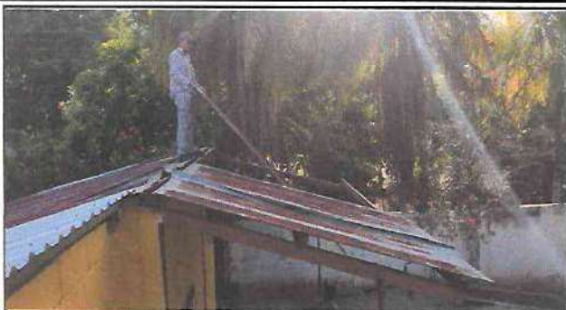
Foto 1: Módulo Aula. Trabajando en la sustitución de lámina por lámina troquelada cal. 26.
