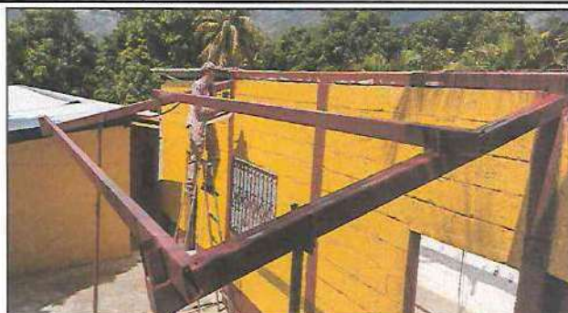
Foto 2: Realización del mantenimiento (pintura) en estructura metálica de techo.
