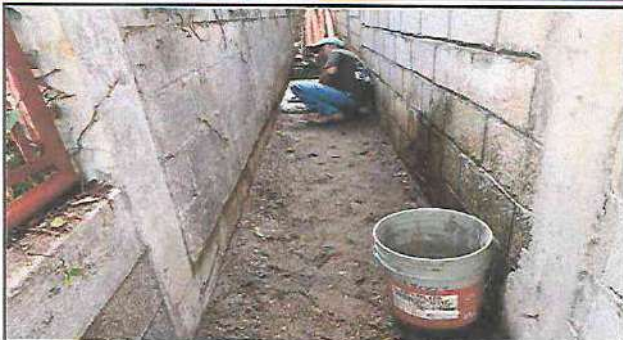
Foto 13: Módulo Red de Drenaje. Trabajando en mantenimiento red de drenaje (reposición de tubería + reposición de concreto).
