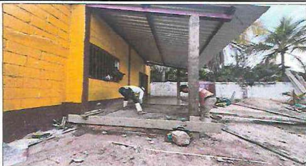
Foto 7: Demolición de piso de concreto y sustitución de torta de concreto en corredor de aula.
