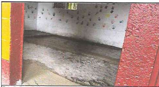
Foto 5: Demolición de piso de torta de concreto y sustitución de torta de concreto dentro de aula.
