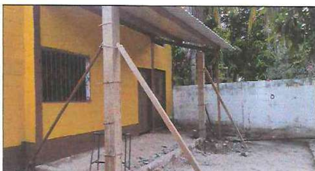
Foto 9: Trabajando en sustitución de columnas de metal por columnas de concreto de 2.50 metros de altura.
