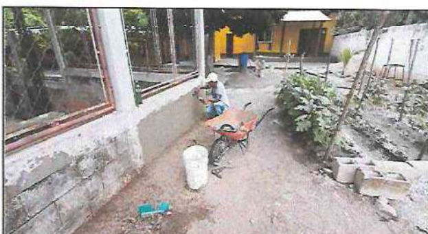
Foto 15: Módulo Muro Perimetral. Trabajando en repello y cernido en muro perimetral.
