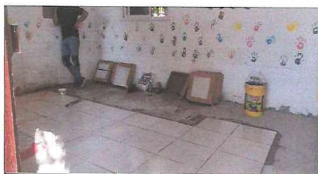
Foto 6: Trabajando en instalación de piso cerámico en aula.
