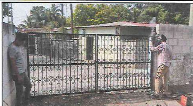
Foto 14: Módulo Portón. Trabajando en mantenimiento de portón de metal entrada principal (pintura anticorrosiva)
