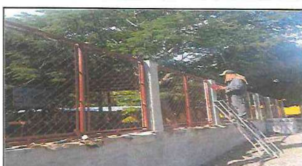
Foto 16: Trabajando en mantenimiento de malla y pintura en tubos de metal en muro perimetral.
