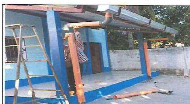
Foto 12: Trabajando en instalación de tubo PVC y sus accesorios para bajada de agua pluvial.
