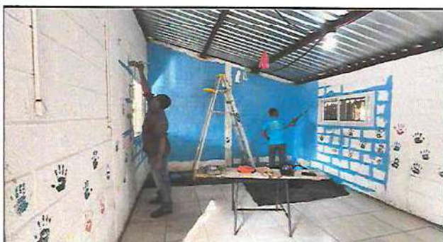
Foto 3: Aplicación de pintura en muros interiores y exteriores, en muros de block rústico.
