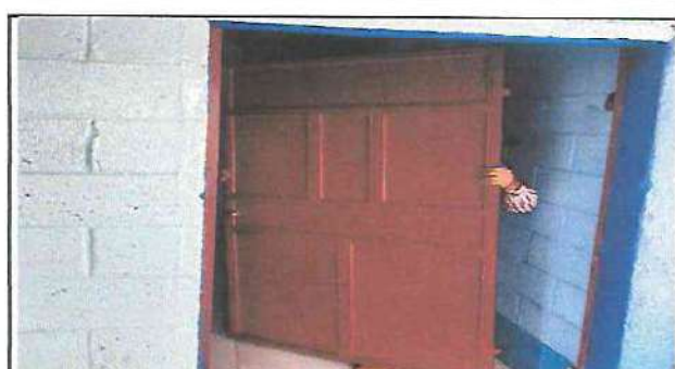
Foto 10: Realización de mantenimiento de puertas de metal (corte + pintura)
