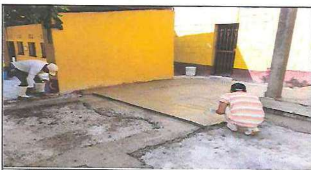
Foto 17: Módulo Losa de Patio. Trabajando en Demolición y sustitución de torta de piso de concreto en patio.
