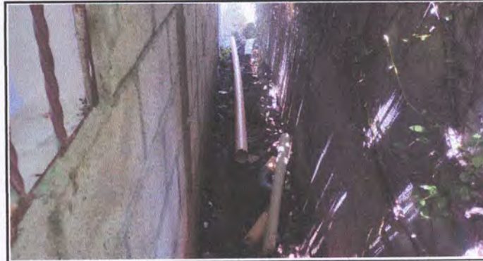
Foto 10: Módulo Red de Drenaje. Mantenimiento red de drenaje (reposición de tubería + reposición de concreto).
