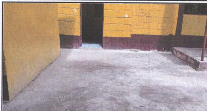
Foto 14: Módulo Losa de Patio. Demolición y retiro de piso de concreto existente en patio y sustitución de torta de piso de concreto en patio.
