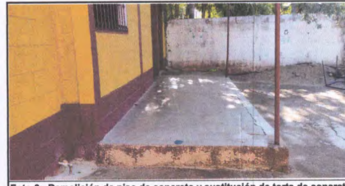
Foto 6: Demolición de piso de concreto y sustitución de torta de concreto en corredor de aula e instalación de piso cerámico.
