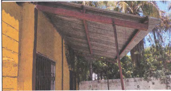
Foto 2: Mantenimiento (pintura) en estructura metálica de techo.
