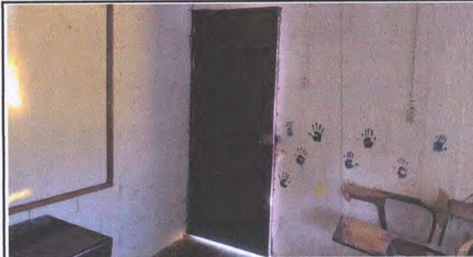
Foto 8: Mantenimiento de puertas de metal (corte + pintura)
