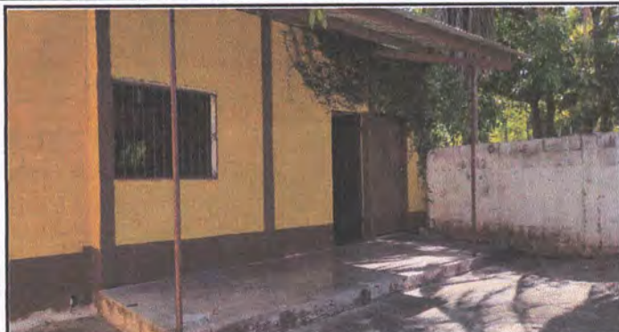
Foto 7: Sustitución de columnas de metal por columnas de concreto de 2.50 de altura.
