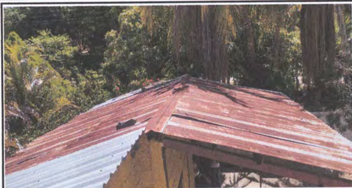
Foto1: Módulo Aula. Sustitución de lámina por lámina troquelada cal. 26.
