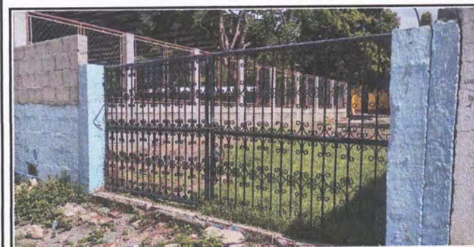
Foto 11: Módulo Porton. Mantenimiento de porton de metal entrada principal (pintura anticorrosiva).
