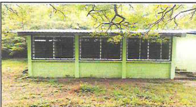
FOTOGRAFIA: SUSTITUCION DE VENTANAS DE PVC, SUSTITUCION DE LAMINA EN MODULO DE DIRECCION
