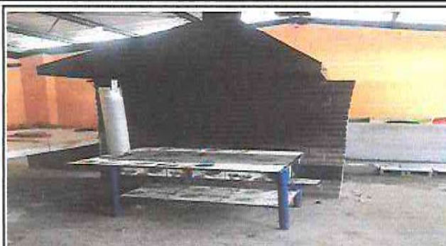
FOTOGRAFIA: SUSTITUCION DE ESTUFA RURAL (COMPLETA) INCLUYE CHIMENEA Y PLANCHA DE METAL EN MODULO DE COCINA
