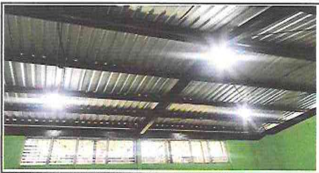
FOTOGRAFIA: SUSTITUCION DE SISTEMA ELECTRICO, MANTENIMIENTO DE ESTRUCTURA METALICA EN MODULO DE COMPUTACION
