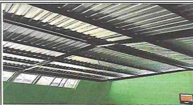
FOTOGRAFIA: MANTENIMIENTO DE ESTRUCTURA METALICA EN MODULO DE COMPUTACION
