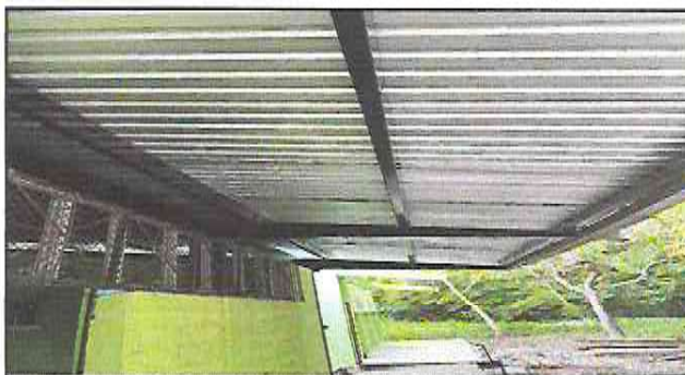
FOTOGRAFIA: SUSTITUCION DE LAMINA EN MODULO DE COMPUTACION
