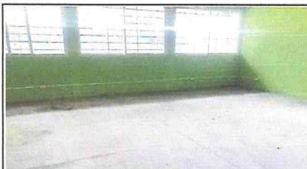
FOTOGRAFIA: SUSTITUCION DE SISTEMA ELECTRICO, MANTENIMIENTO DE ESTRUCTURA METALICA EN MODULO DE DIRECCION
