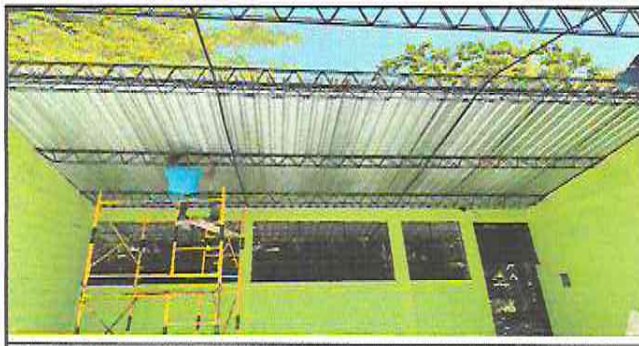
FOTOGRAFIA: SUSTITUCION DE LAMINA EN MODULO DE DIRECCION
