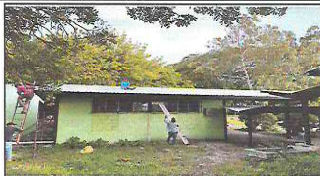
FOTOGRAFIA: SUSTITUCION DE LAMINA MODULO DE COMPUTACION
