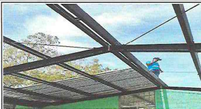
FOTOGRAFIA: SUSTITUCION DE LAMINA MODULO DE COMPUTACION
