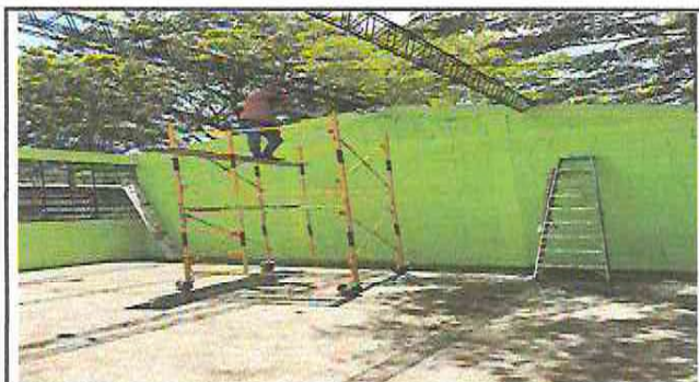
FOTOGRAFIA: MANTENIMIENTO DE ESTRUCTURA METALICA MODULO DE DIRECCION
