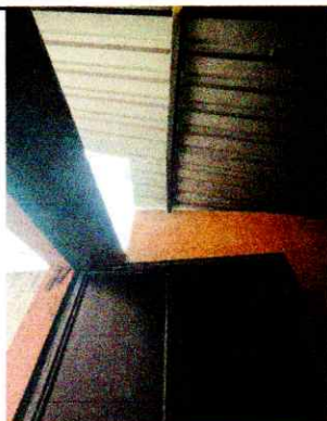
Foto 3: Lámina cortada que no protege de inundaciones
