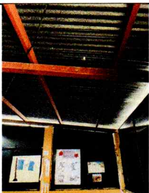
Foto 9: Módulo A, lámina perforada
