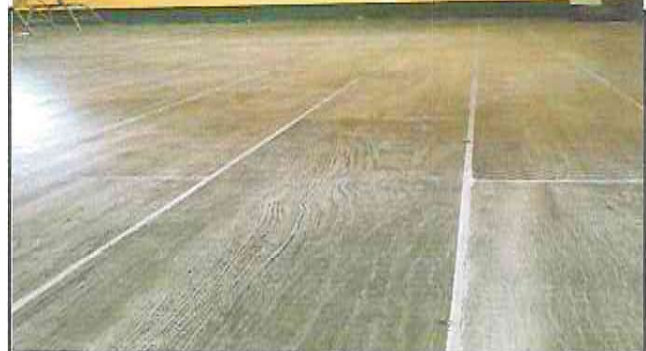
FOTOGRAFIA: SUSTITUCION DE PISO, POR PISO DE PORCELANATO DE 60 X 60 EN MODULO DE AULA
