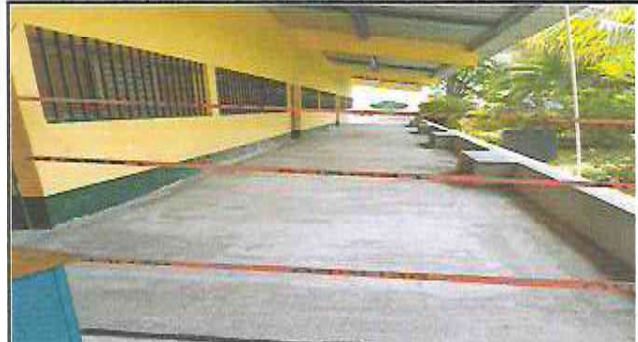
FOTOGRAFIA: SUSTITUCION DE PISO, POR PISO DE PORCELANATO DE 60 X 60 EN MODULO DE CORREDOR
