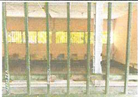
FOTOGRAFIA: PINTURA EN MUROS EN MODULO DE AULA
