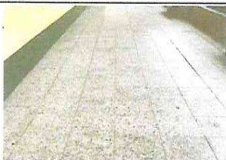
FOTOGRAFIA: SUSTITUCION DE PISO, POR PISO DE PORCELANATO DE 60 X 60 EN MODULO DE CORREDOR
