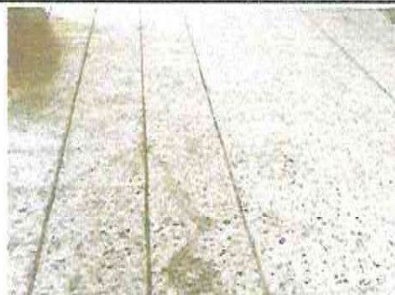
FOTOGRAFIA: SUSTITUCION DE PISO, POR PISO DE PORCELANATO DE 60 X 60 EN MODULO DE CORREDOR
