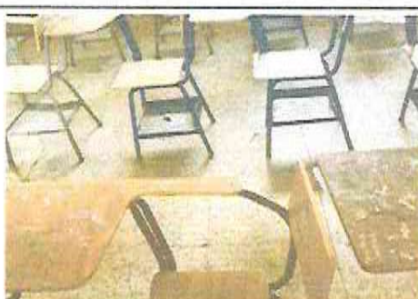
FOTOGRAFIA: SUSTITUCION DE PISO, POR PISO DE PORCELANATO DE 60 X 60 EN MODULO DE AULA
