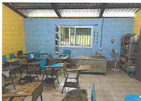
FOTOGRAFIA: SUSTITUCION DE PISO CERAMICO, SUSTITUCION DE VENTANAS PVC EN MODULO DE COMPUTACION
