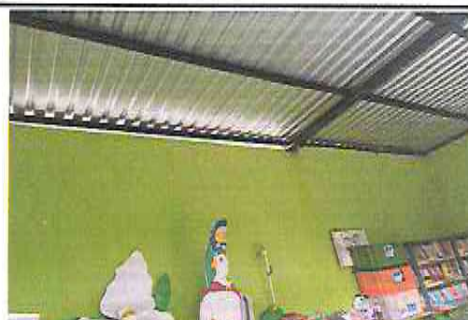
FOTOGRAFIA: SUSTITUCION DE LAMINA, POR LAMINA TROQUELADA CALIBRE 26, SUSTITUCION DE ESTRUCTURA DE SOPORTE DE MADERA, POR METAL EN MODULO DE BIBLIOTECA
