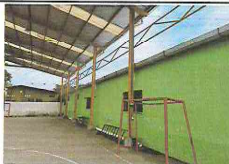
FOTOGRAFIA: SUSTITUCION DE CANAL DE METAL, SUSTITUCION DE BAJADA PLUVIAL DE TUBO PVC DE 3, SUSTITUCION DE TUBERIA PVC DE 6 PARA RECOLECCION DE AGUA DE BAJADAS EN CANAL Y
