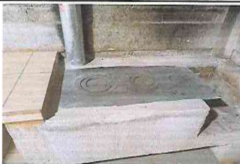
FOTOGRAFIA: SUSTITUCION DE ESTUFA RURAL (COMPLETA) INCLUYE CHIMENEA Y PLANCHA DE METAL EN MODULO DE COCINA
