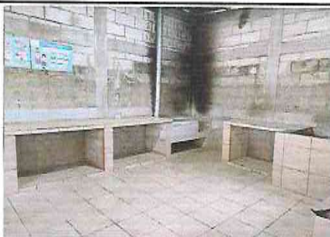
FOTOGRAFIA: SUSTITUCION DE PISO CERAMICO EN MODULO DE COCINA
