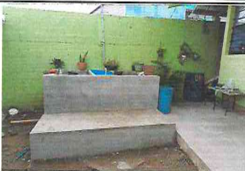
FOTOGRAFIA: SUSTITUCION DE PILA DE DOS LAVADEROS
