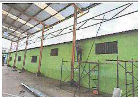
FOTOGRAFIA: SUSTITUCION DE CANAL DE METAL, SUSTITUCION DE BAJADA PLUVIAL DE TUBO PVC DE 3, SUSTITUCION DE TUBERIA PVC DE 6 PARA RECOLECCION DE AGUA DE BAJADAS EN CANAL Y BAJADA
