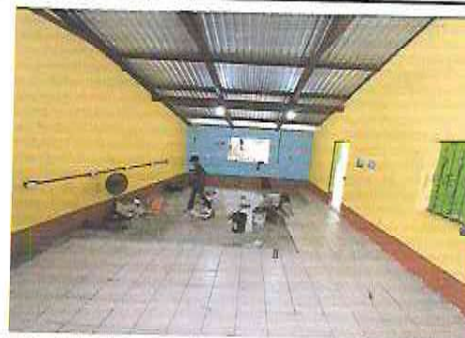
FOTOGRAFIA: SUSTITUCION DE PISO CERAMICO, SUSTITUCION DE VENTANAS PVC EN MODULO DE COMPUTACION
