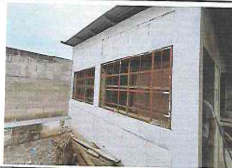
FOTOGRAFIA: SUSTITUCION DE VENTANA DE ESTRUCTURA DE METAL EN MODULO DE COCINA
