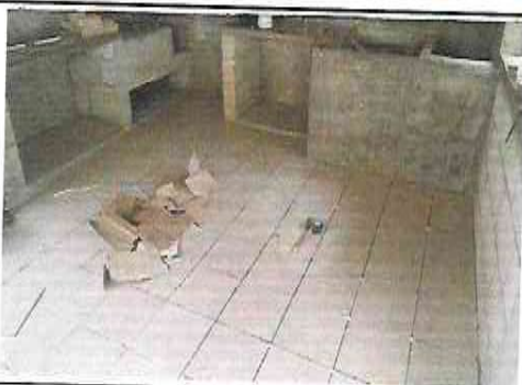
FOTOGRAFIA: SUSTITUCION DE PISO CERAMICO EN MODULO DE COCINA
