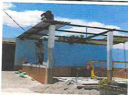
FOTOGRAFIA: SUSUTITUCION DE LAMINA, POR LAMINA TROQUELADA CALIBRE 26, SUSTITUCION DE ESTRUCTURA DE SOPORTE DE MADERA, POR METAL EN MODULO DE ESCENARIO
