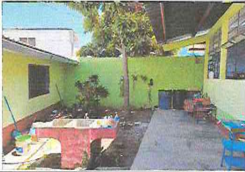
FOTOGRAFIA: SUSTITUCION DE PILA DE DOS LAVADEROS
