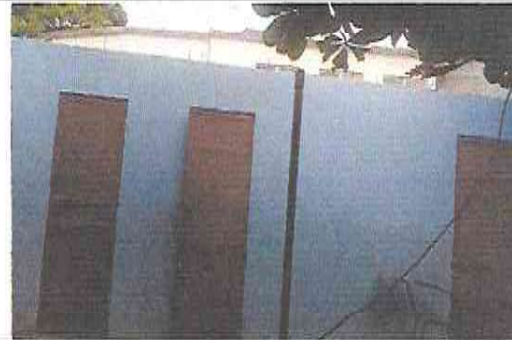
FOTOGRAFIA: SUSTITUCION DE LAMINA, POR LAMINA TROQUELADA CALIBRE 26, SUSTITUCION DE ESTRUCTURA DE SOPORTE DE MADERA, POR METAL EN MODULO DE BAÑOS
