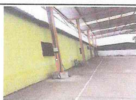
FOTOGRAFIA: SUSTITUCION DE CANAL DE METAL, SUSTITUCION DE BAJADA PLUVIAL DE TUBO PVC DE 3, SUSTITUCION DE TUBERIA PVC DE 6 PARA RECOLECCION DE AGUA DE BAJADAS EN CANAL Y BAJADA
