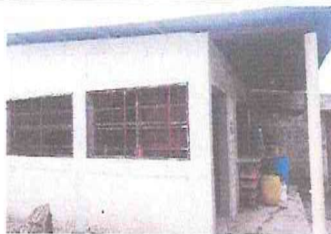
FOTOGRAFIA: SUSTITUCION DE VENTANA DE ESTRUCTURA DE METAL EN MODULO DE COCINA
