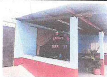
FOTOGRAFIA: SUSUTITUCION DE LAMINA, POR LAMINA TROQUELADA CALIBRE 26, SUSTITUCION DE ESTRUCTURA DE SOPORTE DE MADERA, POR METAL EN MODULO DE ESCENARIO
