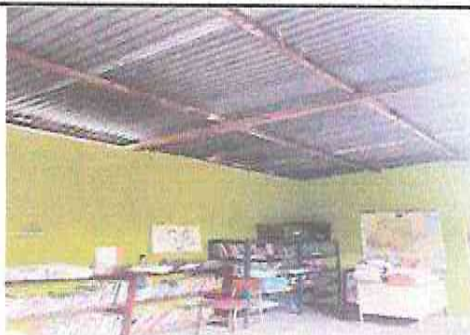
FOTOGRAFIA: SUSTITUCION DE LAMINA, POR LAMINA TROQUELADA CALIBRE 26, SUSTITUCION DE ESTRUCTURA DE SOPORTE DE MADERA, POR METAL EN MODULO DE BIBLIOTECA
