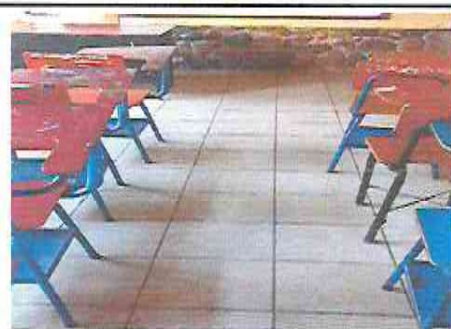
Foto 5 : SUSTITUCION DE TORTA DE CONCRETO POR PISO CERAMICO EN AULA SEGUNDO "C"
