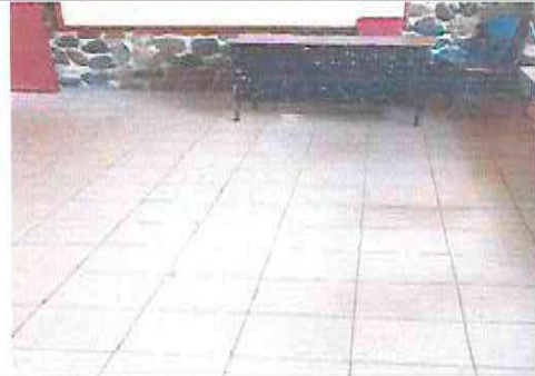
Foto 8 : COLOCACION Y NIVELACION PISO CERAMICO SOBRE PISO DE CONCRETO EN AULA TERCERO "A"
