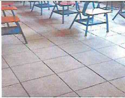
Foto 7 : SUSTITUCION DE TORTA DE CONCRETO POR PISO CERAMICO EN AULA TERCERO "A"
