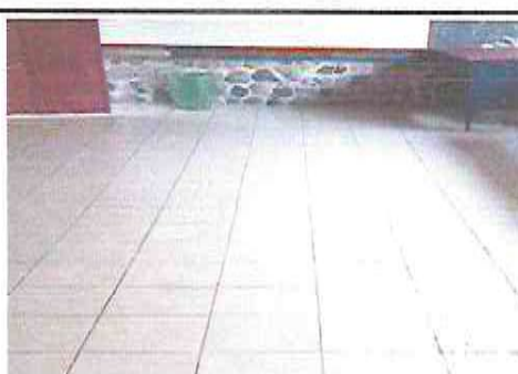
Foto 4 : COLOCACION Y NIVELACION PISO CERAMICO SOBRE PISO DE CONCRETO EN AULA SEGUNDO "B"
