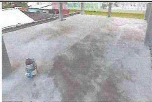
Foto 11: IMPERMEABILIZACIÓN DE LOSA EN LABORATORIO DE COMPUTACION
