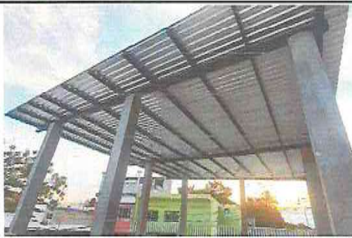
Foto 13: INSTALACION DE TECHO SOBRE LOSA PARA EVITAR ALMACENAMIENTO DE AGUA DE LLUVIA
