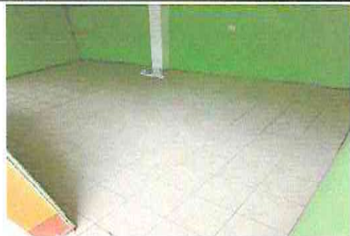
Foto 10 : COLOCACION Y NIVELACION PISO CERAMICO SOBRE PISO DE CONCRETO EN DIRECCION
