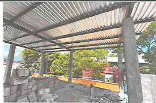
Fotografía 14: INSTALACION DE TECHO
