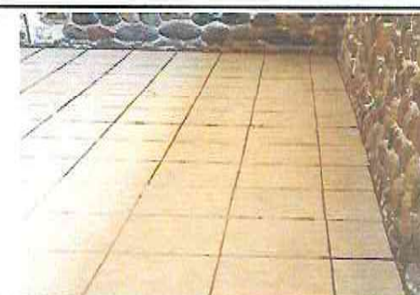
Foto 6 : COLOCACION Y NIVELACION PISO CERAMICO SOBRE PISO DE CONCRETO EN AULA SEGUNDO "C"
