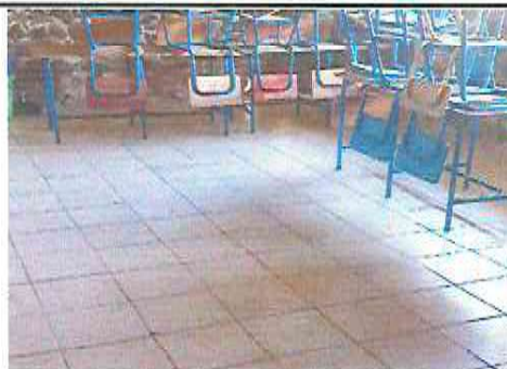
Foto 2 : COLOCACION Y NIVELACION PISO CERAMICO SOBRE PISO DE CONCRETO EN AULA PRIMERO "A"
