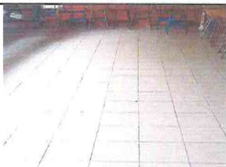
Foto 3 : SUSTITUCION DE TORTA DE CONCRETO POR PISO CERAMICO EN AULA SEGUNDO "B"
