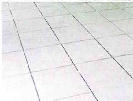
Foto 9 : SUSTITUCION DE TORTA DE CONCRETO POR PISO CERAMICO EN AULA DIRECCION
