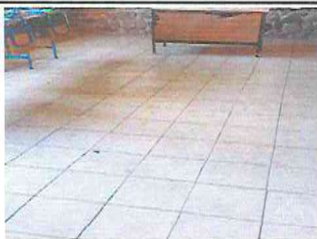
Foto 1 : SUSTITUCION DE TORTA DE CONCRETO POR PISO CERAMICO EN AULA PRIMERO "A"
