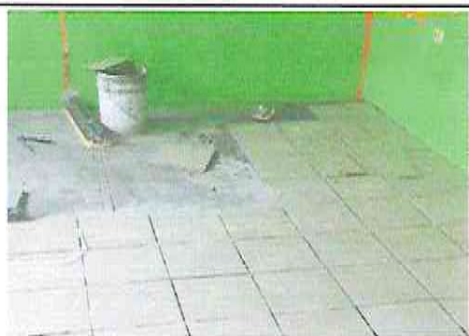
Foto 9 : SUSTITUCION DE TORTA DE CONCRETO POR PISO CERAMICO EN AULA DIRECCION
