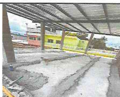
Foto 12: CON LA IMPERMEABILIZACION SE EVITARA LAS FILTRACIONES DE HUMEDAD ENTRE GRIETAS DE LOSA EN LABORATORIO DE COMPUTACION
