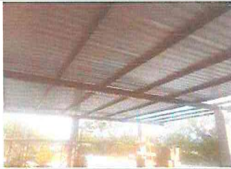
Foto 13: INSTALACION DE TECHO SOBRE LOSA PARA EVITAR ALMACENAMIENTO DE AGUA DE LLUVIA
