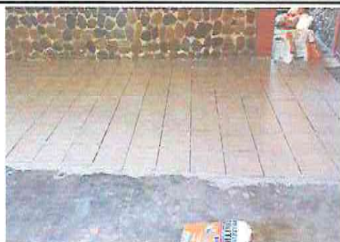
Foto 7 : SUSTITUCION DE TORTA DE CONCRETO POR PISO CERAMICO EN AULA TERCERO "A"
