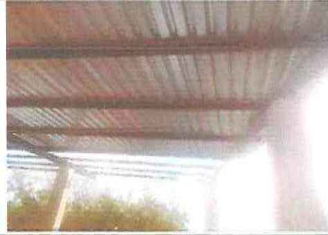
Fotografía 14: INSTALACION DE TECHO
