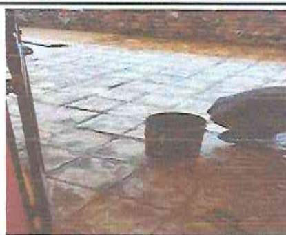
Foto 8 : COLOCACION Y NIVELACION PISO CERAMICO SOBRE PISO DE CONCRETO EN AULA TERCERO "A"
