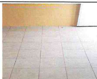
Foto 10 : COLOCACION Y NIVELACION PISO CERAMICO SOBRE PISO DE CONCRETO EN DIRECCION
