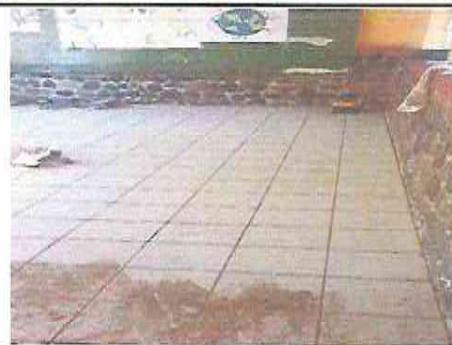
Foto 2 : COLOCACION Y NIVELACION PISO CERAMICO SOBRE PISO DE CONCRETO EN AULA PRIMERO "A"
