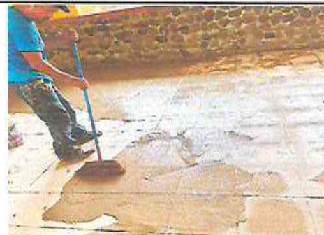
Foto 4 : COLOCACION Y NIVELACION PISO CERAMICO SOBRE PISO DE CONCRETO EN AULA SEGUNDO "B"
