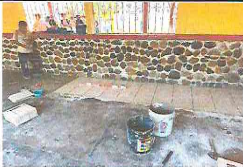
Foto 3 : SUSTITUCION DE TORTA DE CONCRETO POR PISO CERAMICO EN AULA SEGUNDO "B"
