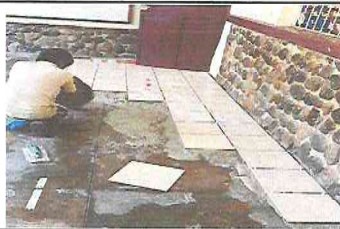
Foto 5 : SUSTITUCION DE TORTA DE CONCRETO POR PISO CERAMICO EN AULA SEGUNDO "C"
