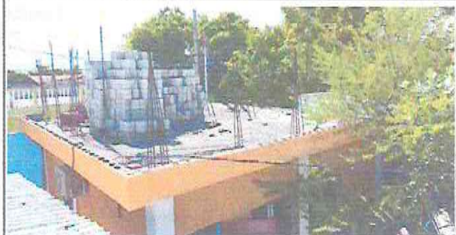
Fotografía 14: INSTALACION DE TECHO
