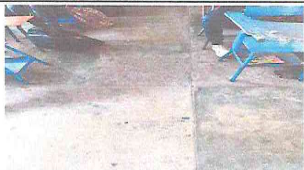
Foto 2 : COLOCACION Y NIVELACION PISO CERAMICO SOBRE PISO DE CONCRETO EN AULA PRIMERO "A"
