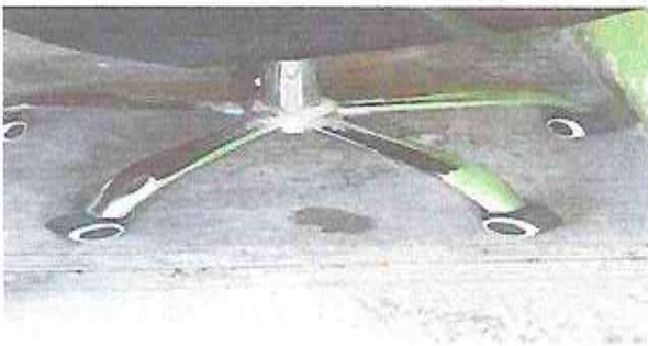
Foto 9 : SUSTITUCION DE TORTA DE CONCRETO POR PISO CERAMICO EN AULA DIRECCION
