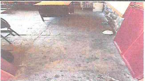
Foto 3 : SUSTITUCION DE TORTA DE CONCRETO POR PISO CERAMICO EN AULA SEGUNDO "B"
