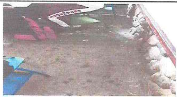
Foto 4 : COLOCACION Y NIVELACION PISO CERAMICO SOBRE PISO DE CONCRETO EN AULA SEGUNDO "B"
