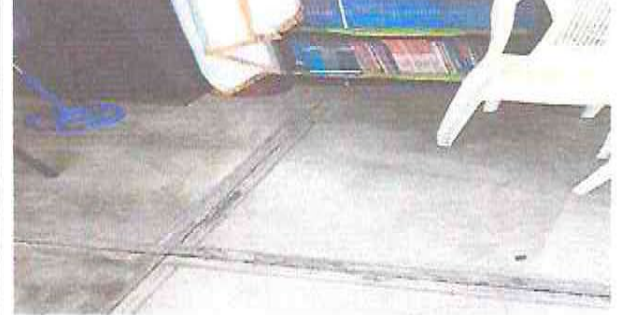
Foto 10 : COLOCACION Y NIVELACION PISO CERAMICO SOBRE PISO DE CONCRETO EN DIRECCION
