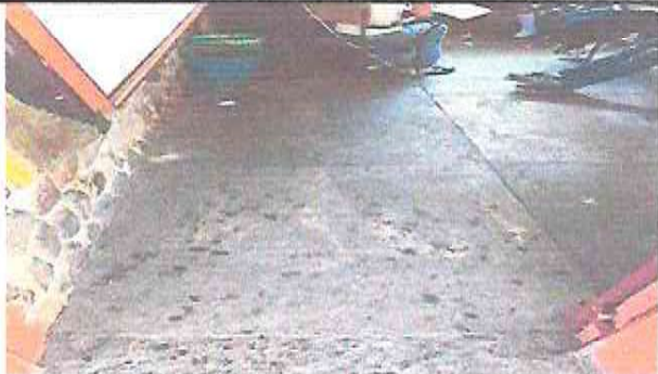
Foto 1 : SUSTITUCION DE TORTA DE CONCRETO POR PISO CERAMICO EN AULA PRIMERO "A"
