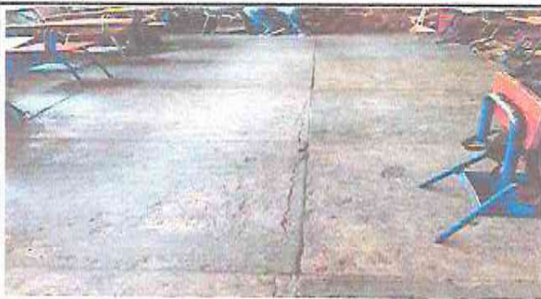
Foto 5 : SUSTITUCION DE TORTA DE CONCRETO POR PISO CERAMICO EN AULA SEGUNDO "C"
