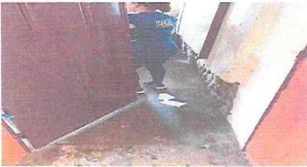
Foto 7 : SUSTITUCION DE TORTA DE CONCRETO POR PISO CERAMICO EN AULA TERCERO "A"
