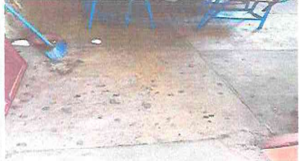
Foto 8 : COLOCACION Y NIVELACION PISO CERAMICO SOBRE PISO DE CONCRETO EN AULA TERCERO "A"
