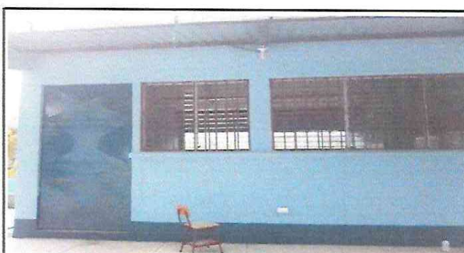
Foto 4: PINTADO DE AULA Y ARREGLADO DE SISTEMA ELECTRICO
