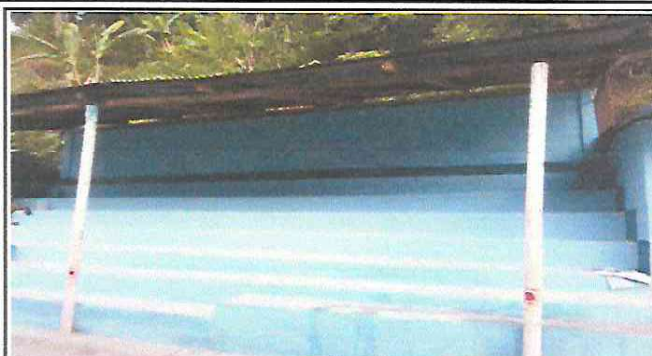
Foto 2: GRADAS DE ESEÑARIO
