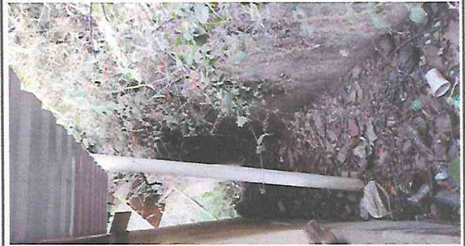
Foto 2: MURO DE CONTENCIÓN
