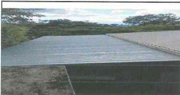
Foto 5: CUBIERTA DE LAMINA
