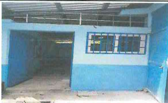
Foto1: PUERTA DE METAL NUEVA
