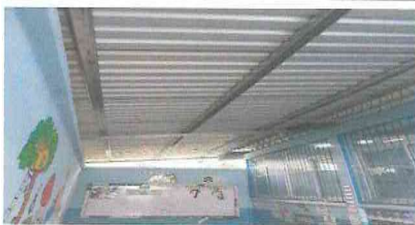
Foto 4: CUBIERTA DE LAMINA NUEVA
