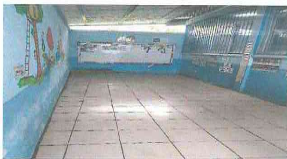
Foto 3: PISO CERAMMICO EN LUGAR DE TORTA DE CEMENTO
