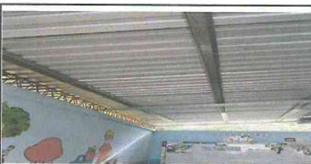
Foto 6: CUBIERTA DE LAMINA
