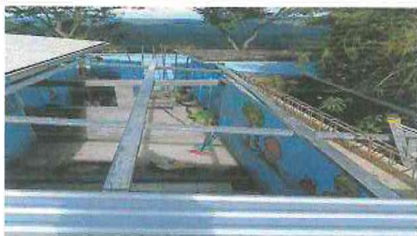
Foto 1: COLOCANDO ESTRUCTURA DE METAL Y LAMINA
