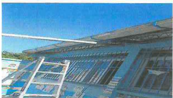
Foto 3: COLOCANDO ESTRUCTURA DE METAL
