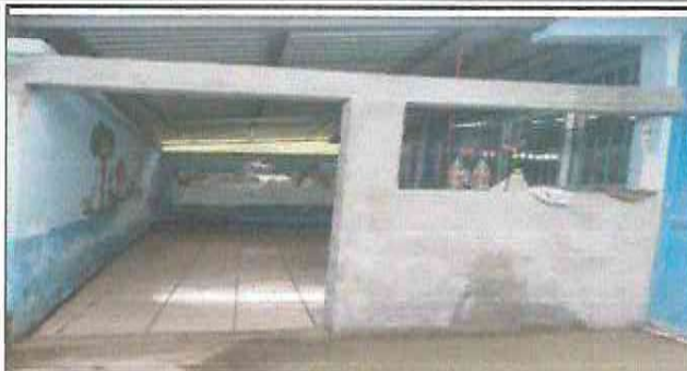
Foto 2: REPELLANDO PARED Y TALLANDO PUERTA Y VENTANA
