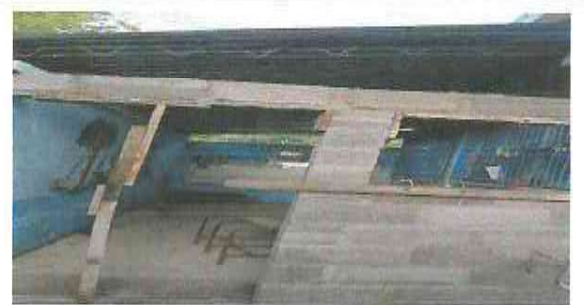
Foto 5: TRABAJOS EN PUERTA Y VENTANA
