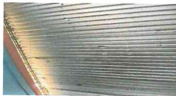
Foto 3: CUBIERTA DE LAMINA
