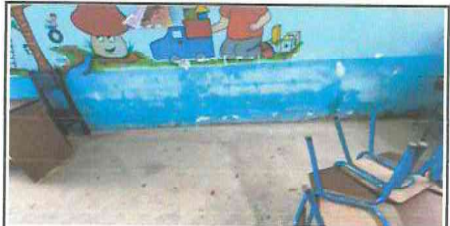
Foto 6: SUSTITUCION DE PISO
