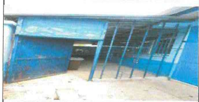
Foto 4: SUSTITUCION DE PUERTA
