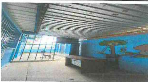
Foto 5: SUSTITUCION DE PISO
