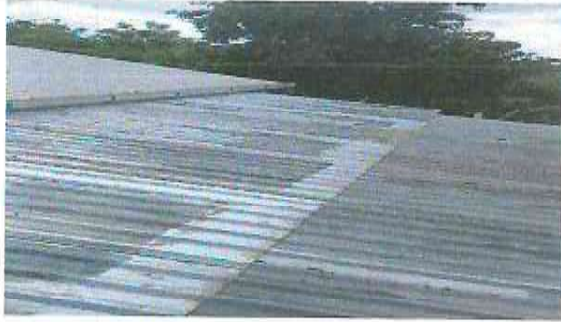
Foto 1: CUBIERTA DE LAMINA
