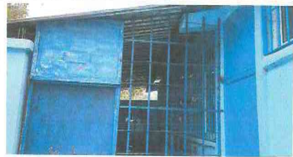
Foto 2: SUSTITUCION DE PUETA Y VENTANA
