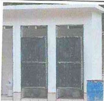
Foto 5: Sustitución de cernidos en muros
