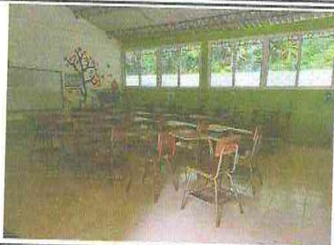
Foto 1: Instalación de piso cerámico en aulas.
