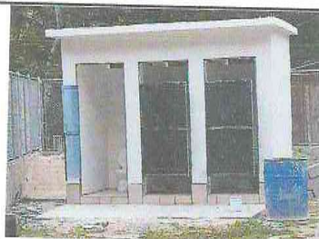
Foto 4: Sustitución de techo de lámina por concreto.
