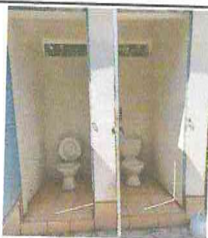
Foto 3: Instalación de piso cerámico
