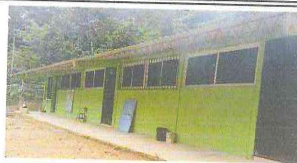
Foto 2: Sustitución de ventanas de metal y vidrio por ventanas de PVC.
