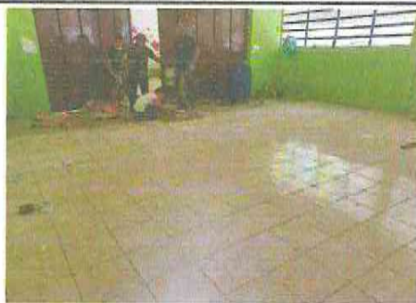
Foto1: Instalación de piso cerámico en aulas.
