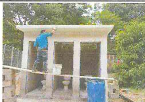
Foto 4: Sustitución de techo de lámina por concreto.
