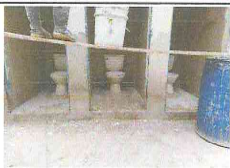
Foto 5: Sustitución de cernidos en muros
