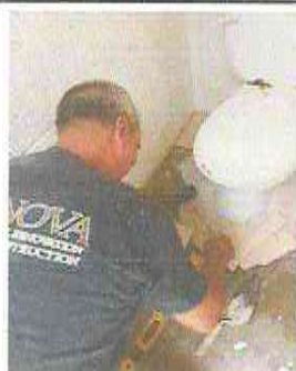
Foto 3: Instalación de piso cerámico
