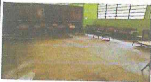
FOTO 1: Instalación de piso cerámico en aulas.
