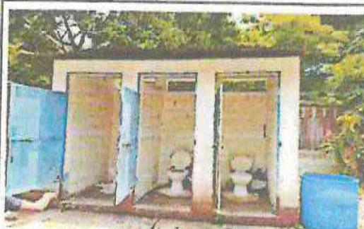
FOTO 4: Trabajos en baños, concreto, piso cerámico y cerridos.
