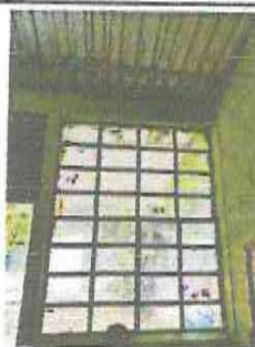
FOTO 6: Trabajos en ventanas de PVC.
