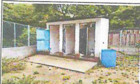
FOTO 3: Trabajos en baños, concreto, piso cerámico y cerridos.
