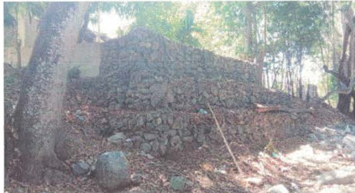
REPARACION DE MURO DE CONTENCIÓN
