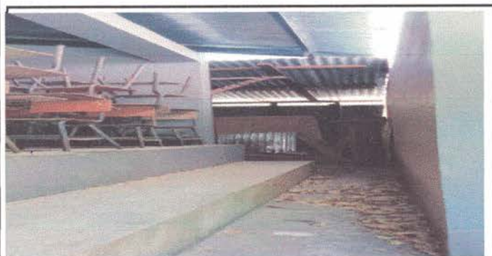
REPARACION DE BANQUETA DE CONCRETO
