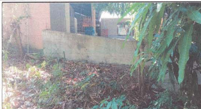
REPARACION DE MURO DE CONTENCIÓN
