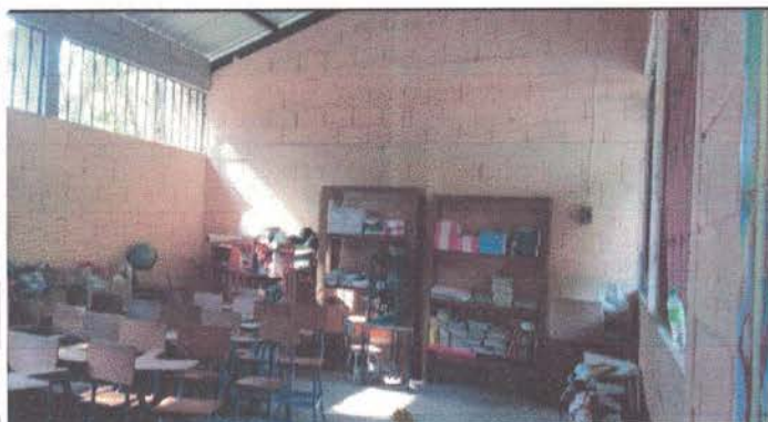
PINTURA EN MUROS INTERIORES DE AULA
