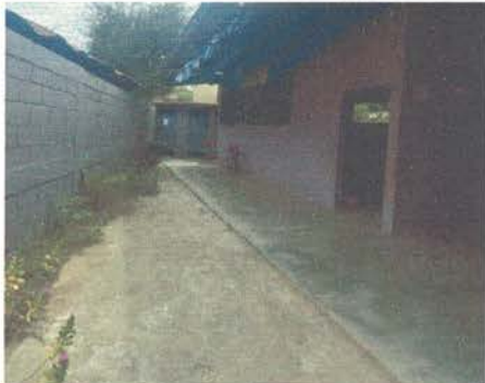
Foto 1: Trámiento a Base de Piso Líquido Existente para Cambio a PISO CERAMICO ANTIDESLIZANTE para MODULO DE AULAS, DIRECCIÓN, CORREDOR DE AULAS Y EN COCINETA.
