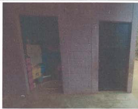
Foto 10: Levantando de Pared h=1.00mts. Para posteriormente Fabricar e Instalar 1 Balcón Metálico de 1.00 x 1.10 mts.
