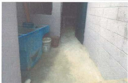
Foto 9: Impermeabilizar Deposito de Pila de Concreto Existente.
