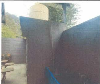
Foto 7: Debe instalarse Caja para Valvulas, Llave Cheque, Cambiar Chorro e Independizar la Subida de Agua al Deposito de la Bajada de manera Individual para ambas.
