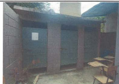
Foto 4: Este Renglón contempla la Reparación, Lijando la Pintura Existente y la Aplicación de Pintura Anticorrosiva en 2 Manos para Puertas y Balcones, así como también cambio de 2 Chapas.
