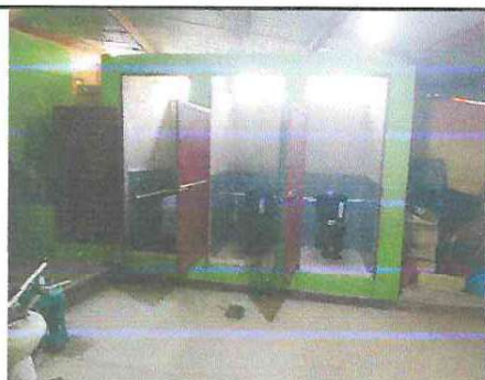
Foto 3: INSTALACION DE PISO CERAMICO EN BAÑOS
