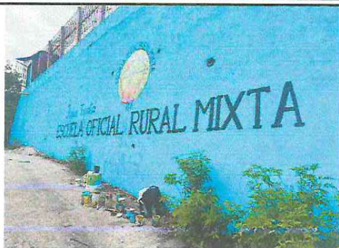
Foto 1: APLICACIÓN DE PINTURA EN MUROS
