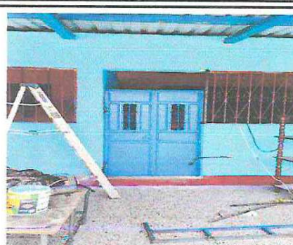
Foto 2: MANTENIMIENTO A PUERTA
