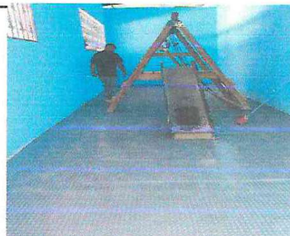
Foto 4: SUSTITUCION DE PISO
