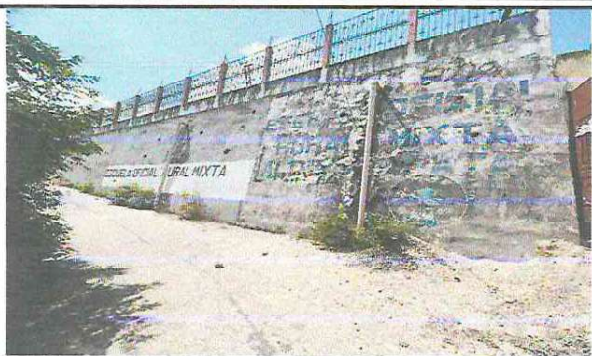
Foto 1: APLICACIÓN DE PINTURA EN MUROS
