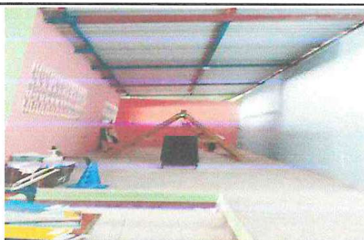
Foto 4: SUSTITUCION DE PISO
