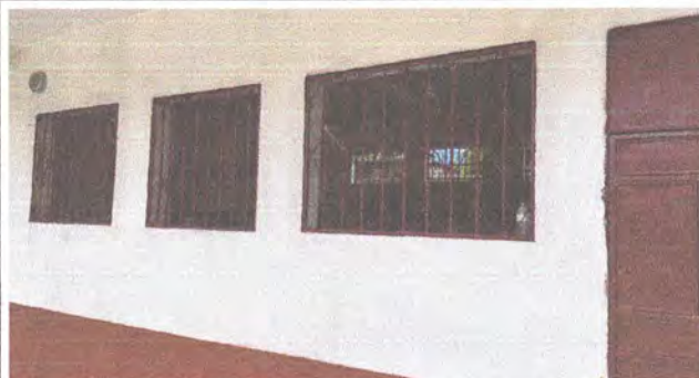
FABRICACION E INSTALACION DE VENTANAS PVC AULA 2
