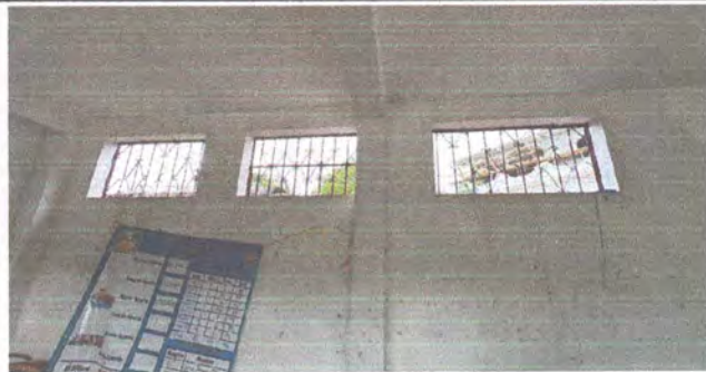
FABRICACION E INSTALACION DE VENTNAS PVC
