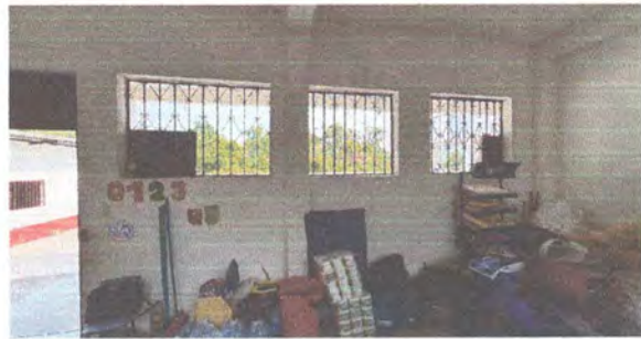
PINTURA EN MUROS EXTERIORES E INTERIORES AULA 1
