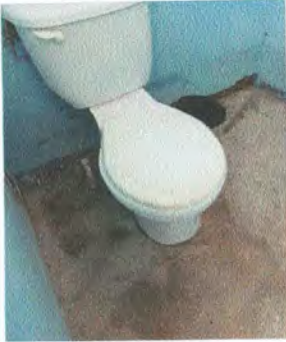
Foto1: sustitución de inodoros
