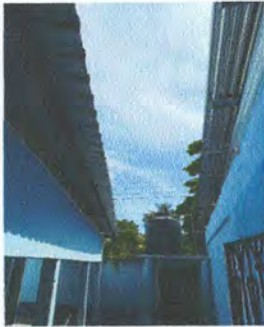
Foto 3: Instalación de cubierta de lámina
