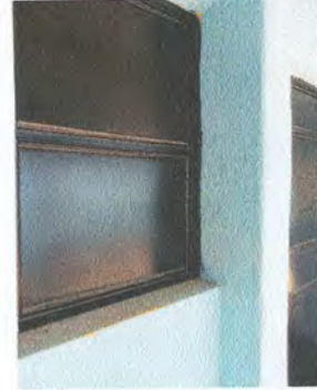
Foto 2: Mantenimiento a ventanas
