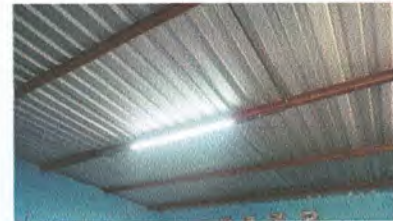
Foto 6: sustitución de focos ahorradores
