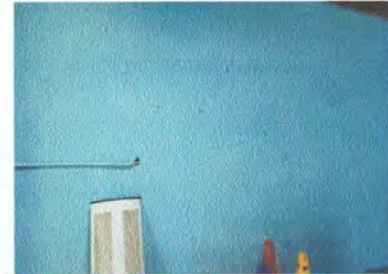
Foto 6: Instalación de unidades de fuerza
