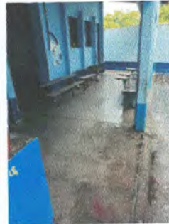
Foto 2: Instalación de piso cerámico
