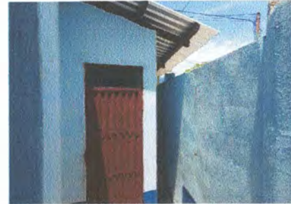
Foto 4: Cambio de puerta de baño, cambio de soporte y cubierta de lámina
