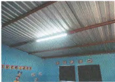
Foto 5: Instalación de unidades de luz
