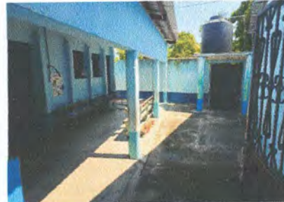
Foto 4: Pintura en muros interiores y exteriores
