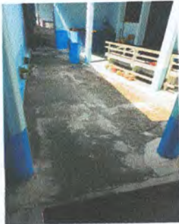
Foto1: Reparación de torta de cemento
