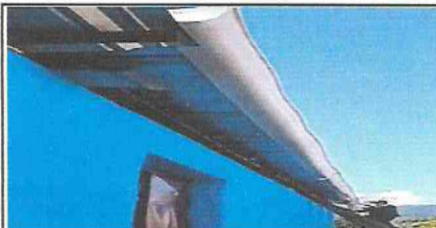
SUSTITUCIÓN DE ESTRUCTURA Y CANALES PVC FINALIZADO
