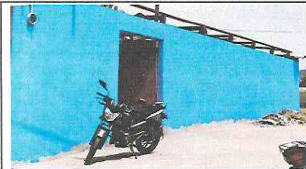
REPARACION DE MURO PERIMETRAL DE BLOCK
