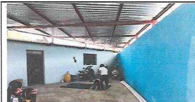
CUBIERTA DE LÁMINA TROQUELADA FINALIZADA
