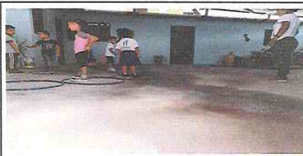
PLANCHA DE CONCRETO FINALIZADA
