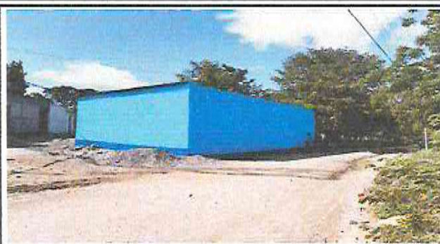
REPELLO EN MURO TERMINADO
