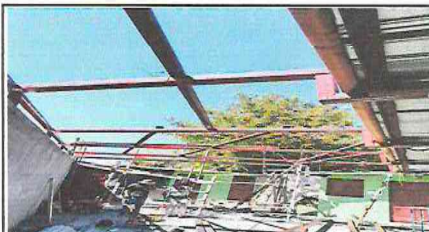
SUSTITUCIÓN DE ESTRUCTURA
