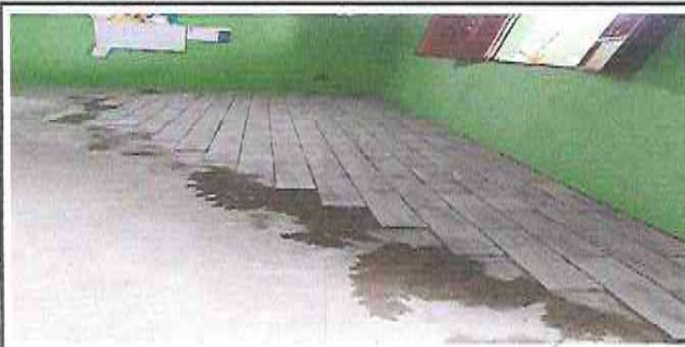
COLOCACIÓN DE PISO CERÁMICO
