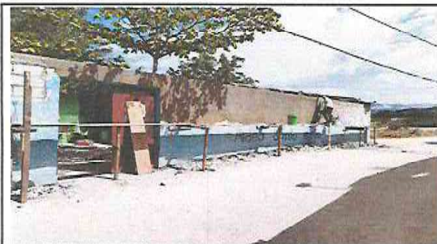
REPARACION DE MURO PERIMETRAL DE BLOCK
