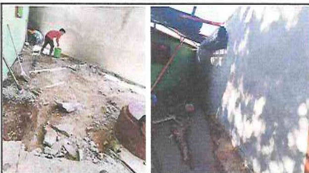
REPARACION PLANCHA DE CONCRETO
