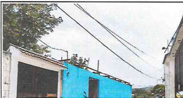
CAMBIO DE LÁMINA POR LÁMINA TROQUELADA
