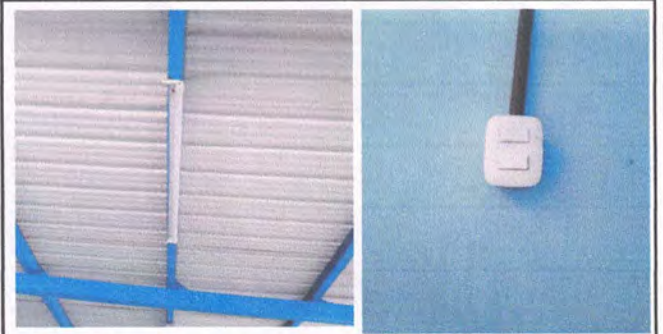
Foto 6: reparación del sistema electrico
